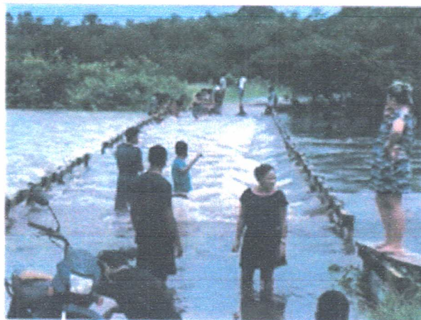
FOTO 08: Ponte do Peritoró Grande
