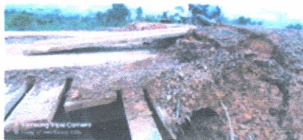
FOTO 03: Ponte na estrada do Cristal
