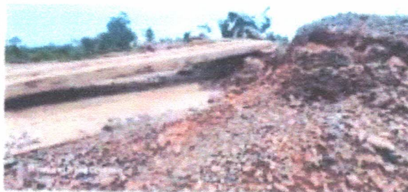
FOTO 02. Ponte na estrada do Cristal
