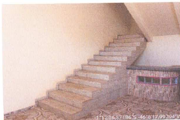
FOTO 12 - ÁREA DE ACESSO - TÉRREO
