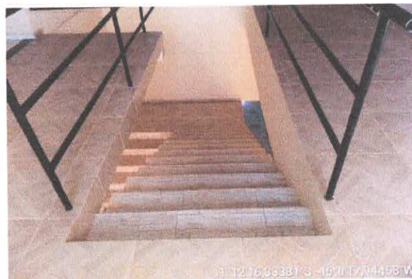
FOTO 10 - ESTRUTURA DE ACESSO (ESCALA)
