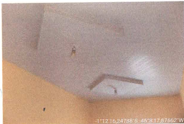
FOTO 09 - INSTALAÇÕES E ACESSÓRIOS ELÉTRICOS
