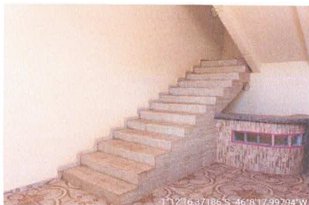
FOTO 29 - ÁREA DE ACESSO
