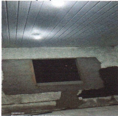
ADEQUAÇÃO DE JANELA
