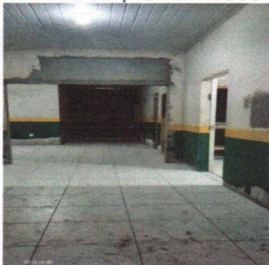
RECOMPOSIÇÃO DE REBOCO
