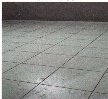
ASSENTAMENTO DE PISO CERÂMICO
