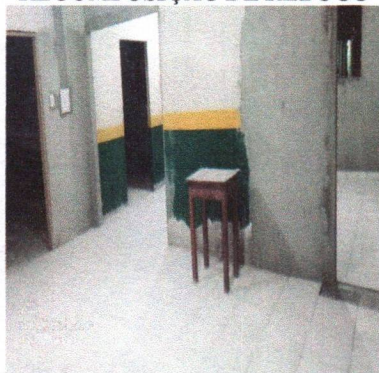
RECOMPOSIÇÃO DE REBOCO
