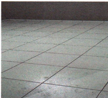
ASSENTAMENTO DE PISO CERÂMICO
