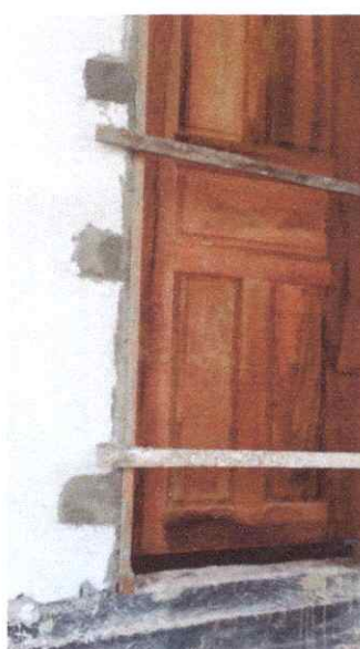
Imagem 04: Construção da E.M.E.F. em Assentamento.
