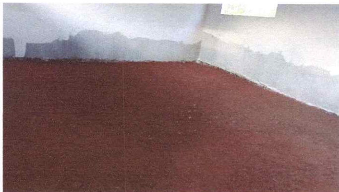
Imagem 01: Construção da E.M.E.F. em Assentamento.
