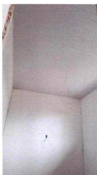
Imagem 05: Construção da E.M.E.F. em Assentamento.
