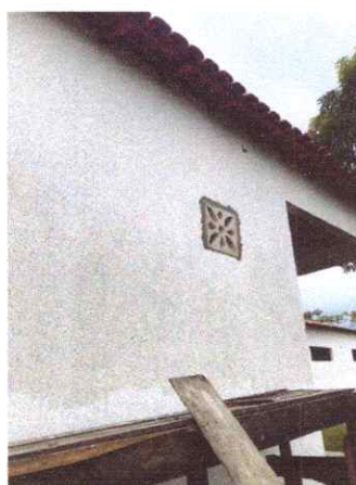
Imagem 07: Construção da E.M.E.F. em Assentamento.
