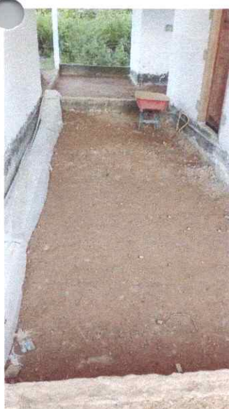
Imagem 03: Construção da E.M.E.F. em Assentamento.
