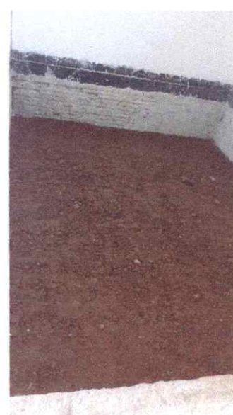
Imagem 06: Construção da E.M.E.F. em Assentamento.
