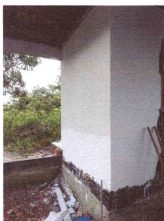
Imagem 08: Construção da E.M.E.F. em Assentamento.
