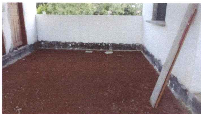
Imagem 02: Construção da E.M.E.F. em Assentamento.
