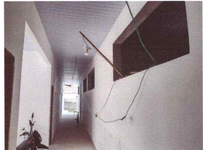
Imagem 06: Reforma da Escola Inezila Santana.
