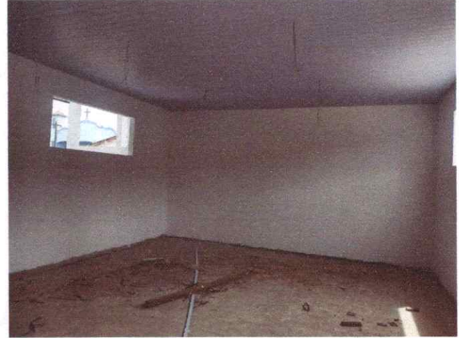
Imagem 04: Reforma da Escola Inezila Santana.
