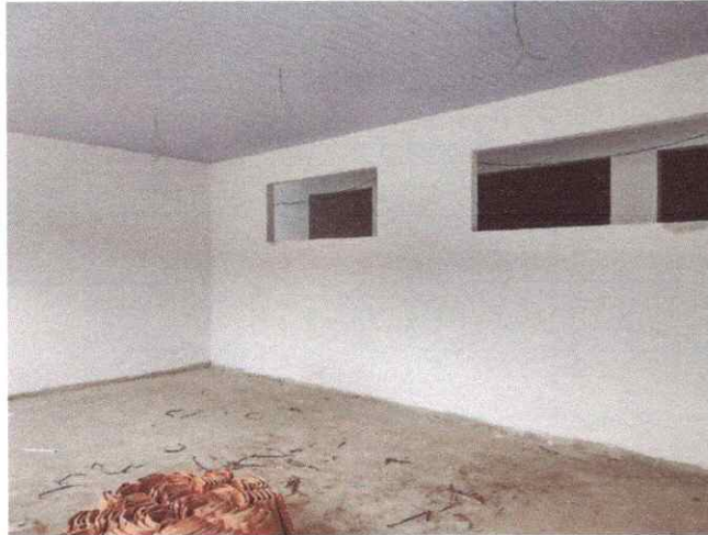
Imagem 03: Reforma da Escola Inezila Santana.
