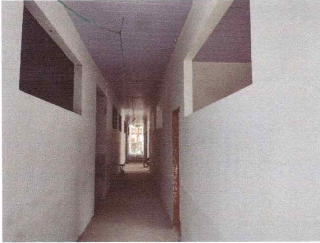
Imagem 01: Reforma da Escola Inezila Santana.
