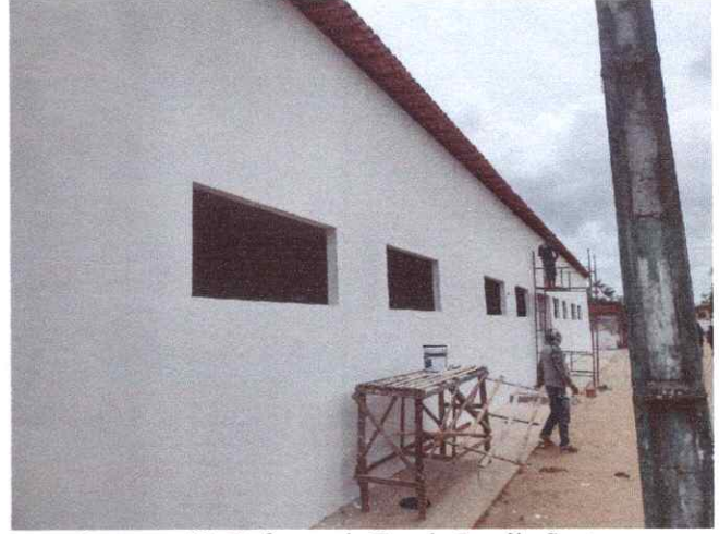
Imagem 02: Reforma da Escola Inezila Santana.
