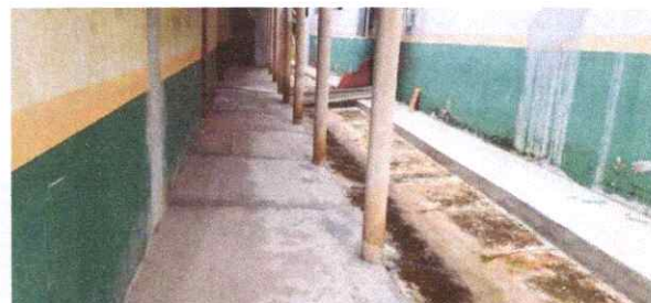
FOTO 08: Separação de blocos
