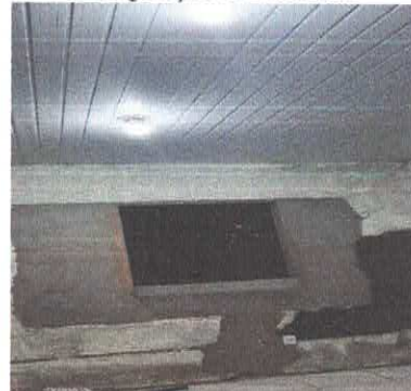
ADEQUAÇÃO DE JANELA
