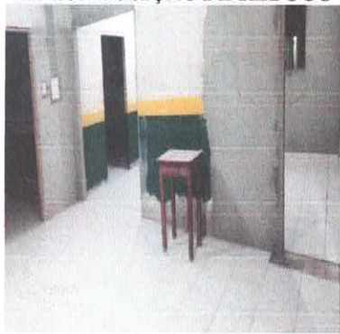
RECOMPOSIÇÃO DE REBOCO
