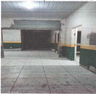
RECOMPOSIÇÃO DE REBOCO
