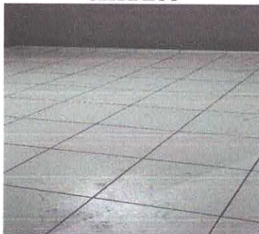
ASSENTAMENTO DE PISO CERÂMICO
