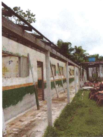
FOTO 02: Reforma de varanda
