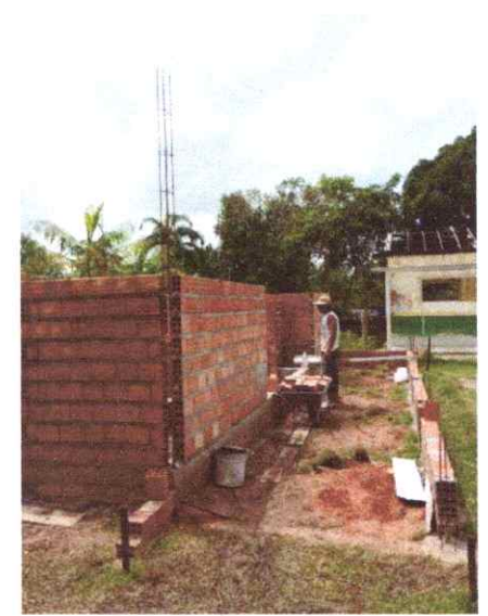
FOTO 06: Construção de novo bloco
