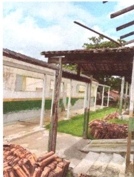
FOTO 05: Reforma da varanda
