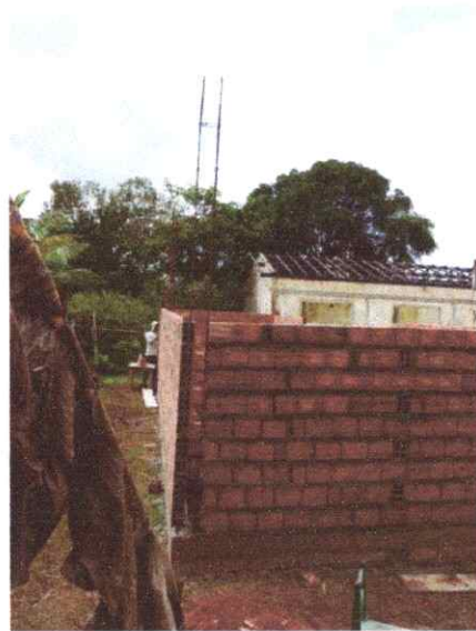
FOTO 04: Construção de novo bloco
