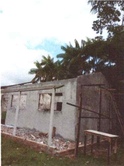
FOTO 01: Vista de reforma
