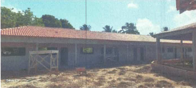
Imagem 01: Construção da E.M.E.F. Ângela Reis
