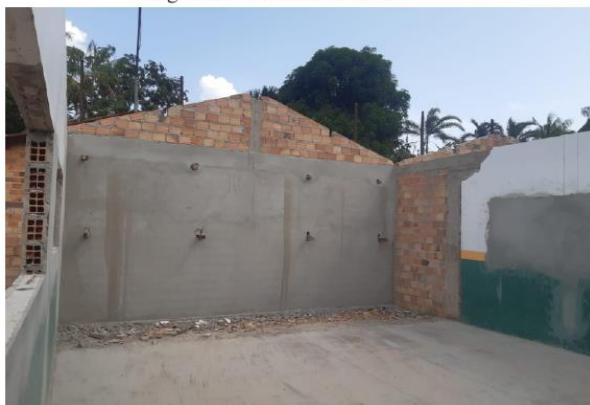
Imagem 03: Reforma de escola.
