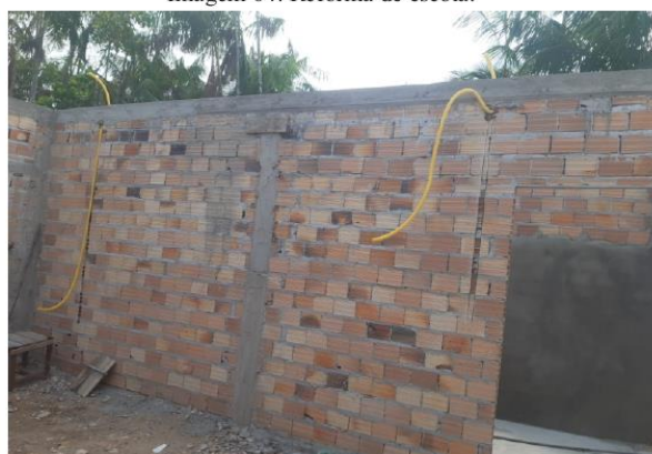
Imagem 06: Reforma de escola.
