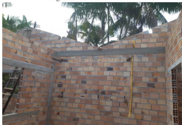
Imagem 04: Reforma de escola.
