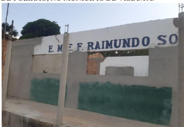
Imagem 01: Reforma de escola.
