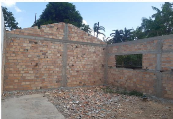
Imagem 07: Reforma de escola.
