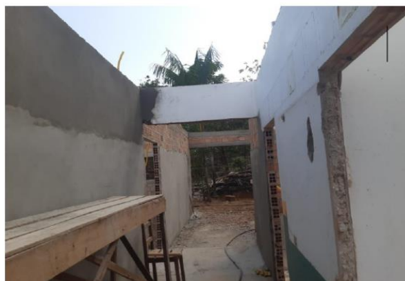
Imagem 02: Reforma de escola.
