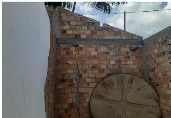
Imagem 08: Reforma de escola.
