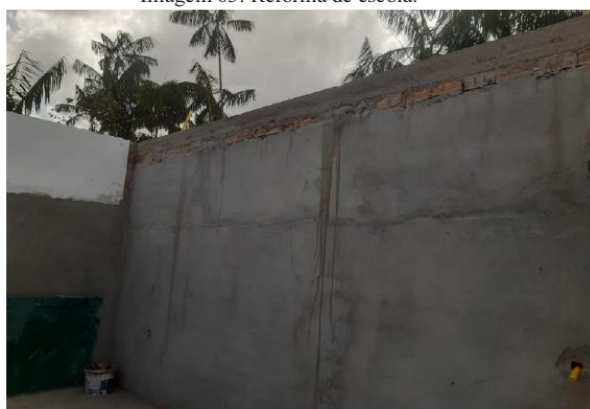
Imagem 05: Reforma de escola.
