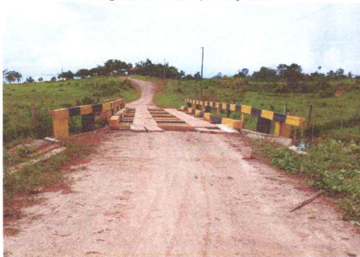
Imagem 05: Construção de ponte.
