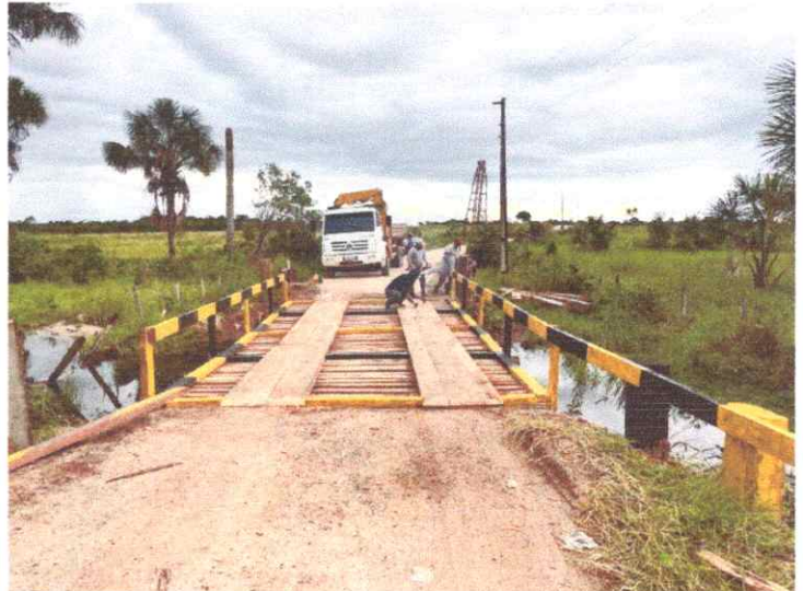
Imagem 04: Construção de ponte.
