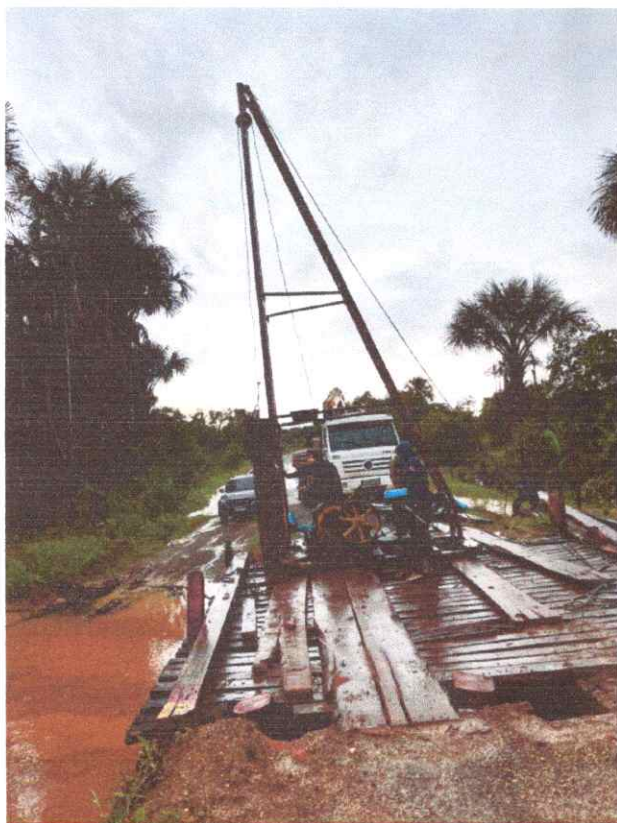
Imagem 10: Construção de ponte.
