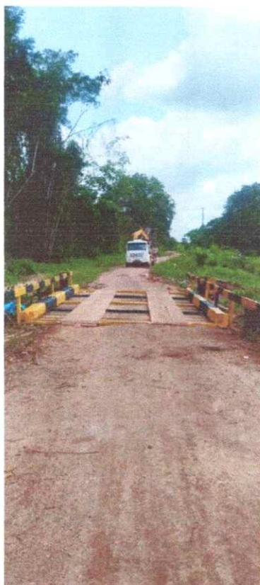
Imagem 08: Construção de ponte.
