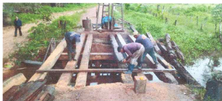
Imagem 11: Construção de ponte.
