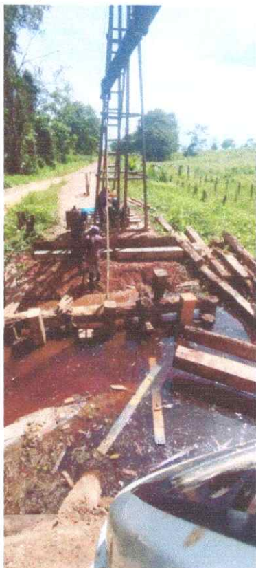
Imagem 07: Construção de ponte.
