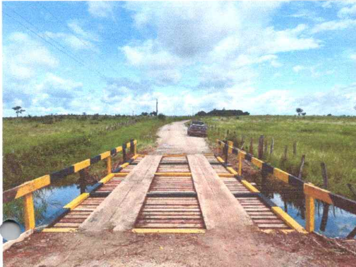
Imagem 01: Construção de ponte.
