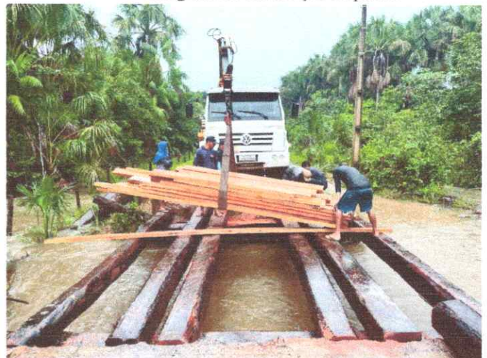
Imagem 06: Construção de ponte.
