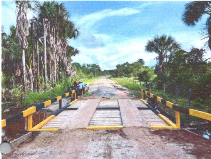
Imagem 03: Construção de ponte.
