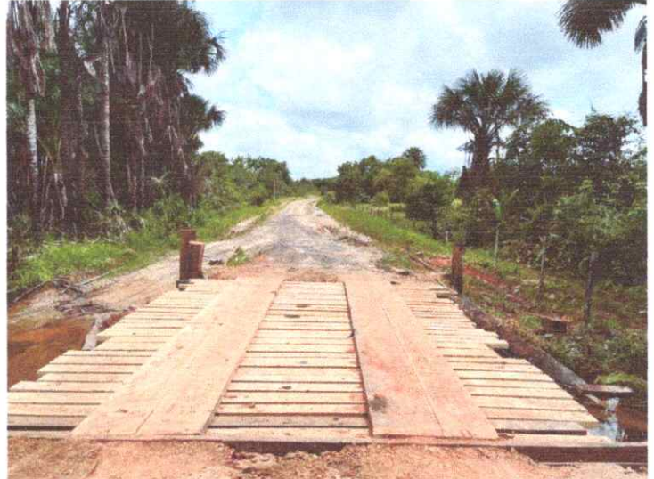
Imagem 02: Construção de ponte.
