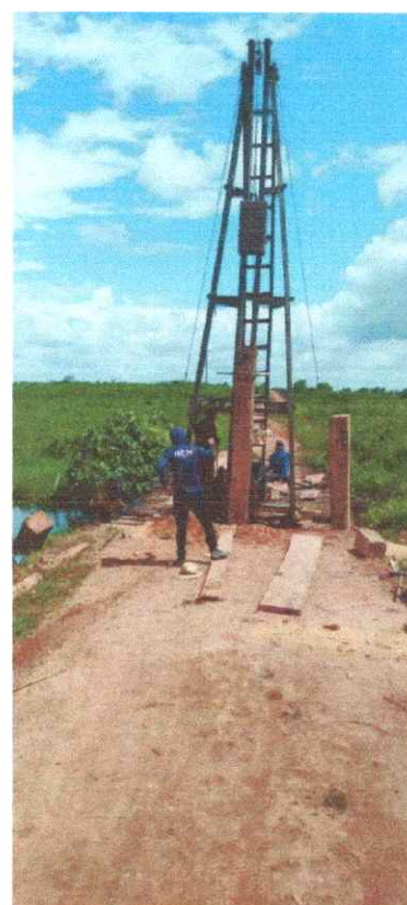
Imagem 09: Construção de ponte.
