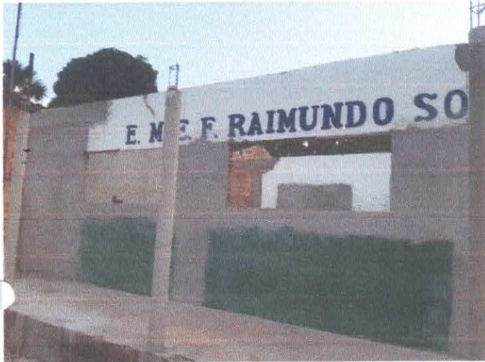
Imagem 01: Reforma de escola.
