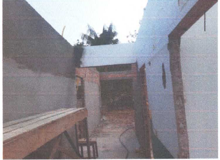
Imagem 02: Reforma de escola.
