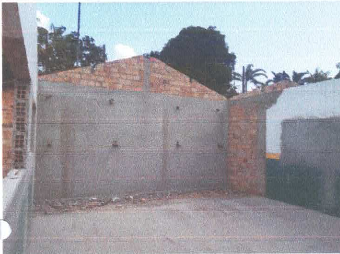
Imagem 03: Reforma de escola.
