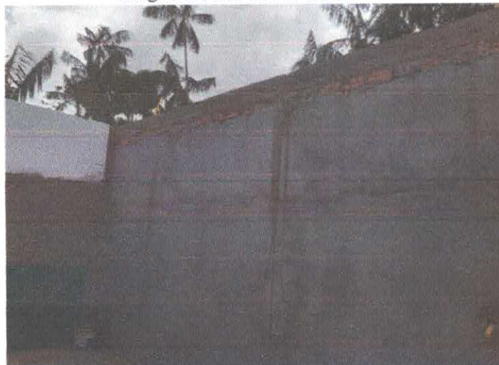
Imagem 05: Reforma de escola.
