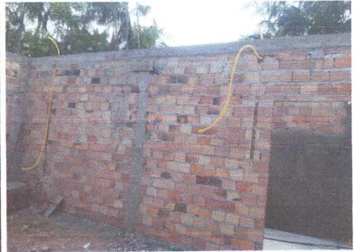
Imagem 06: Reforma de escola.
