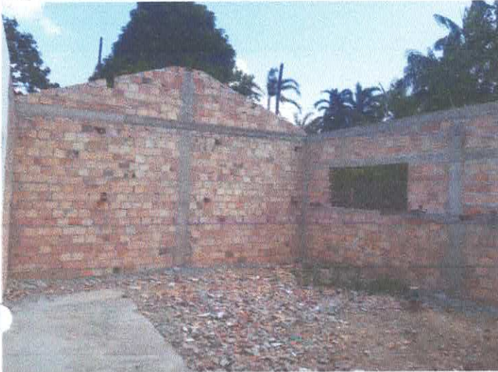
Imagem 07: Reforma de escola.
