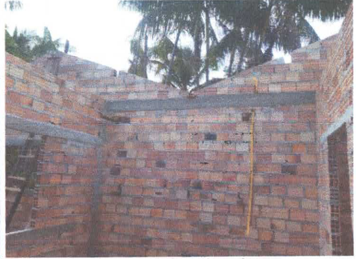
Imagem 04: Reforma de escola.
