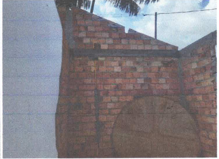
Imagem 08: Reforma de escola.
