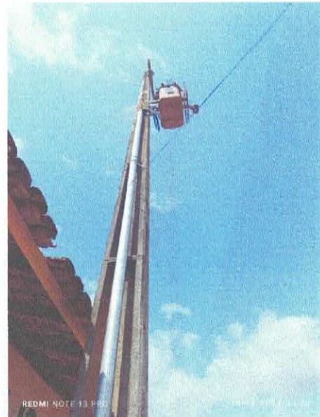
Imagem 03: transformador elétrico.
