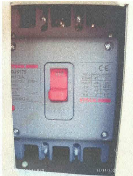
Imagem 02: disjuntor instalado.
