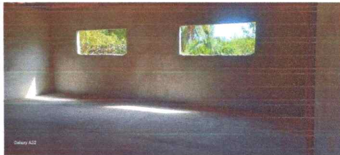
Imagem 02: Construção da E.M.E.F. Ângela Reis
