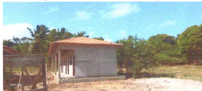
Imagem 05: Construção da E.M.E.F. Ângela Reis
