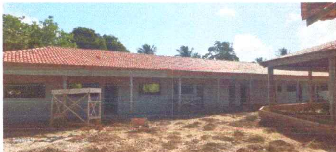
Imagem 01: Construção da E.M.E.F. Ângela Reis
