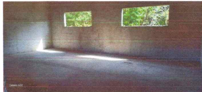
Imagem 06: Construção da E.M.E.F. Ângela Reis
