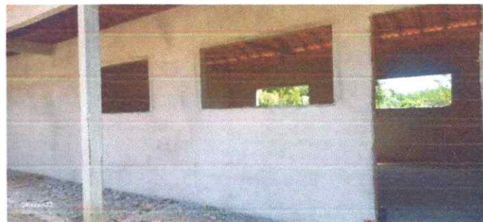
Imagem 04: Construção da E.M.E.F. Ângela Reis
