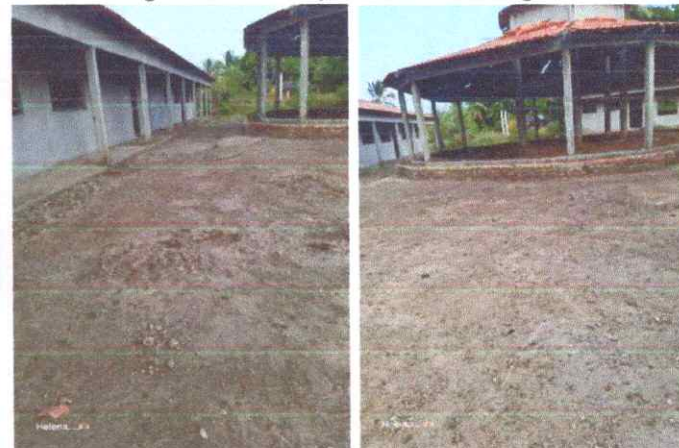
Imagens 08 e 09: Construção da E.M.E.F. Ângela Reis
