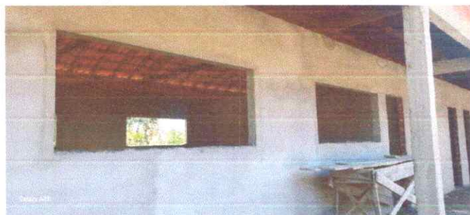
Imagem 03: Construção da E.M.E.F. Ângela Reis
