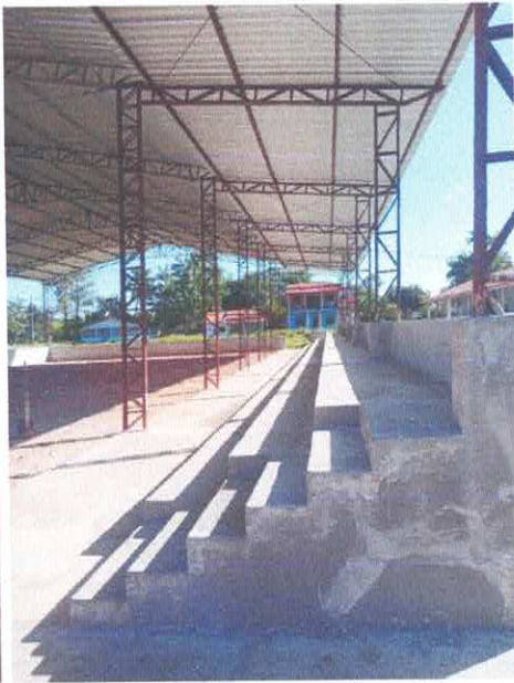
Imagem 02: Construção de quadra poliesportiva.
