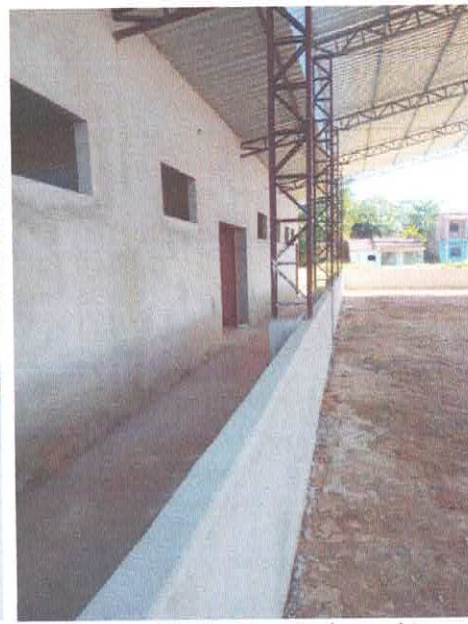
Imagem 06: Construção de quadra poliesportiva.
