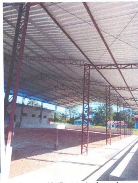
Imagem 03: Construção de quadra poliesportiva.
