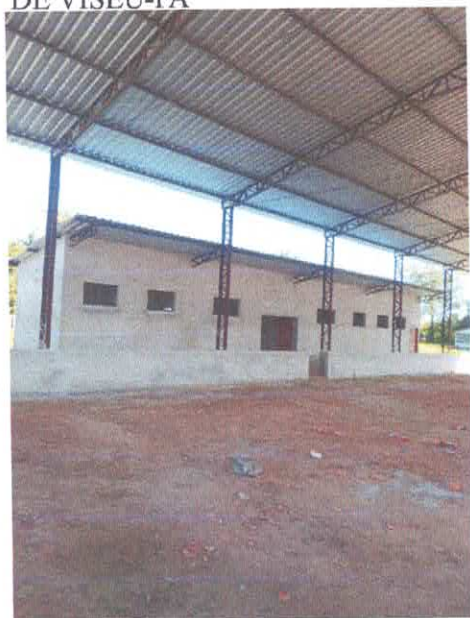
Imagem 01: Construção de quadra poliesportiva.
