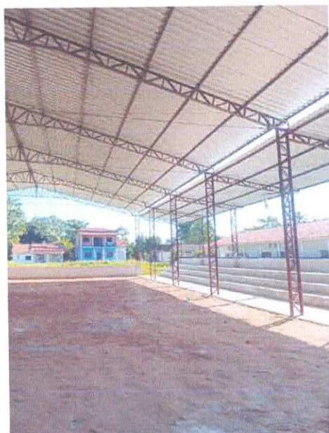
Imagem 04: Construção de quadra poliesportiva.
