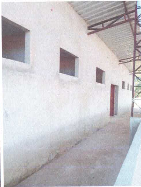
Imagem 05: Construção de quadra poliesportiva.
