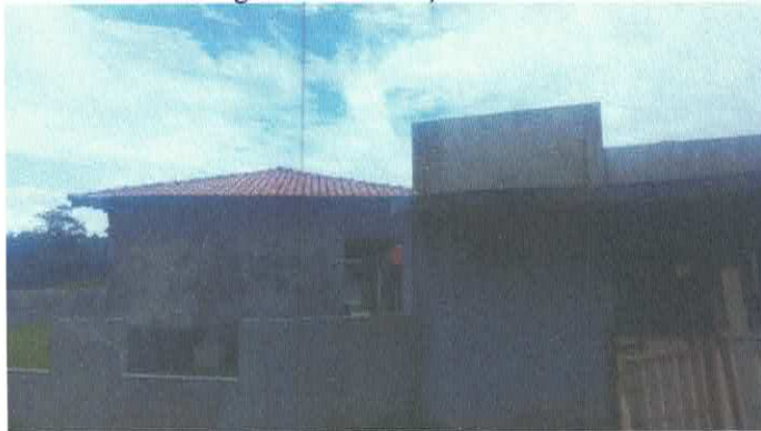
Imagem 03: Construção da escola.
