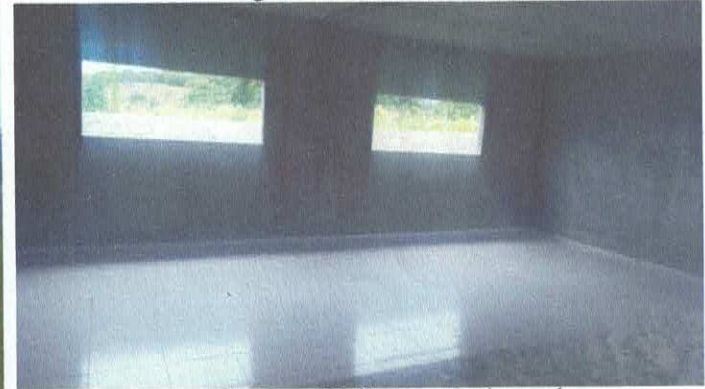
Imagem 06: Construção da escola.
