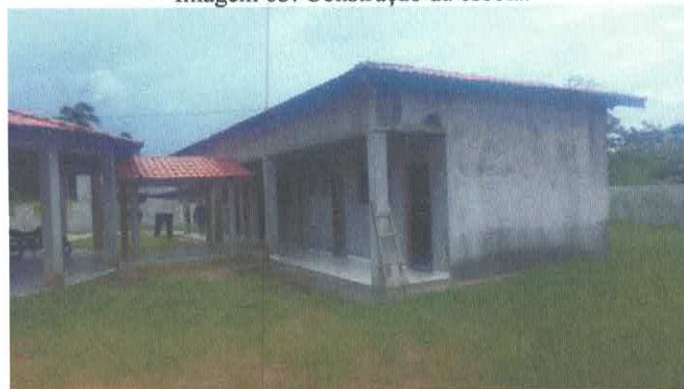
Imagem 05: Construção da escola.
