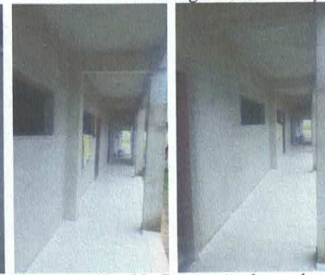
Imagem 08 e 09: Construção da escola.
