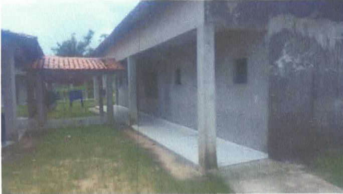
Imagem 01: Construção da escola.
