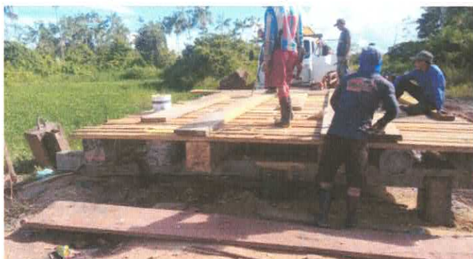
Imagem 11: Construção de ponte - Cristal.
