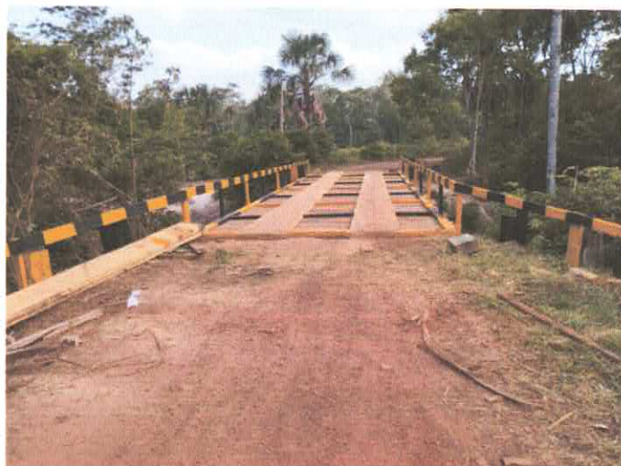
Imagem 10: Construção de ponte - Itambá.
