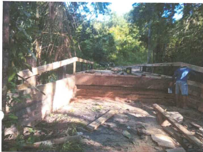
Imagem 07: Construção de ponte - Km 74.
