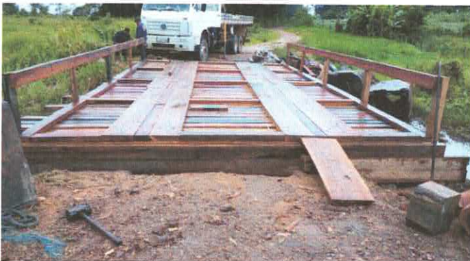
Imagem 06: Construção de ponte - Km 74.
