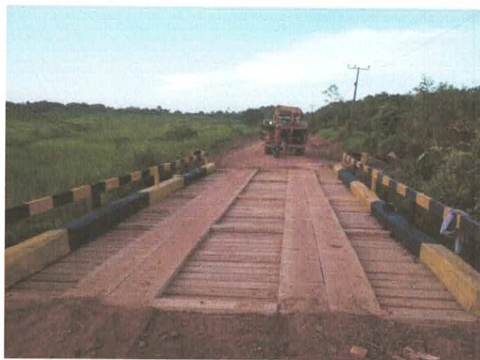
Imagem 02: Construção de ponte - Japim.
