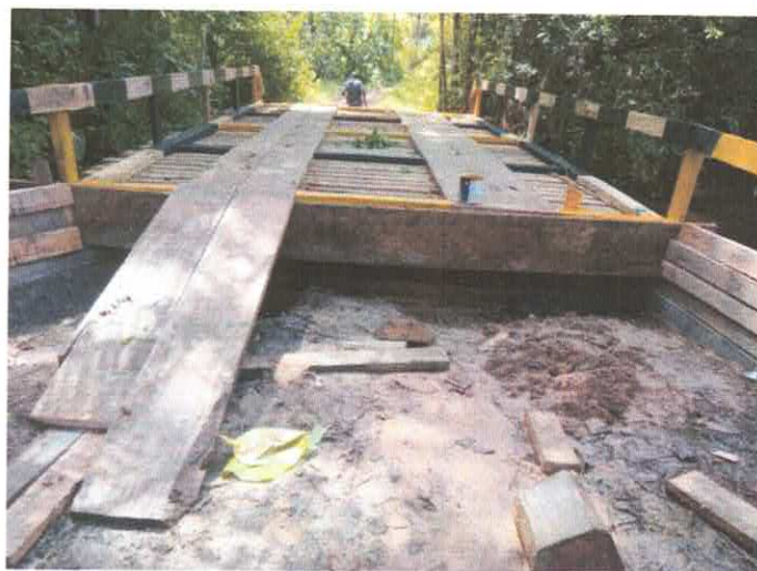
Imagem 08: Construção de ponte - Km 74.
