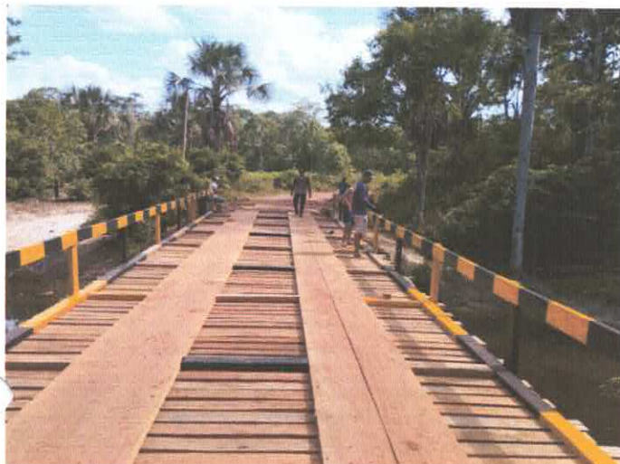
Imagem 09: Construção de ponte - Itambá.
