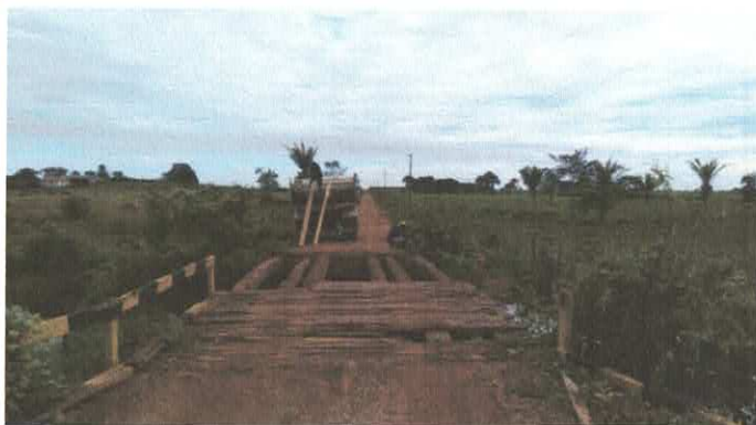
Imagem 04: Construção de ponte - Carrapatinho.
