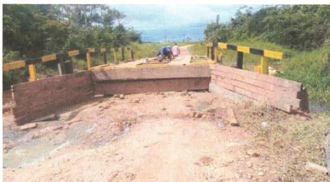
Imagem 12: Construção de ponte - Cristal.
