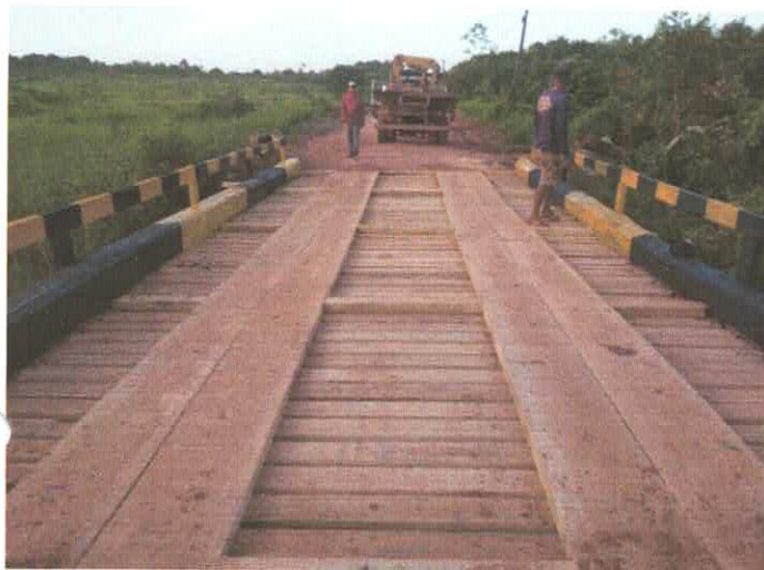
Imagem 01: Construção de ponte - Japim.
