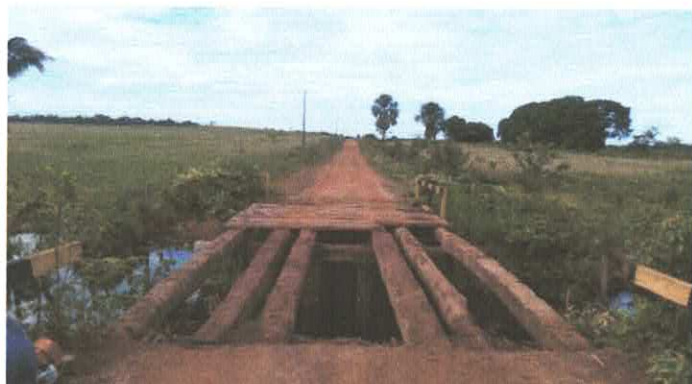
Imagem 03: Construção de ponte - Carrapatinho.
