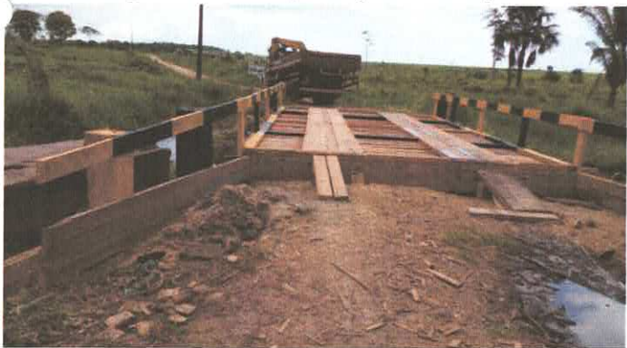
Imagem 05: Construção de ponte - Km 74.
