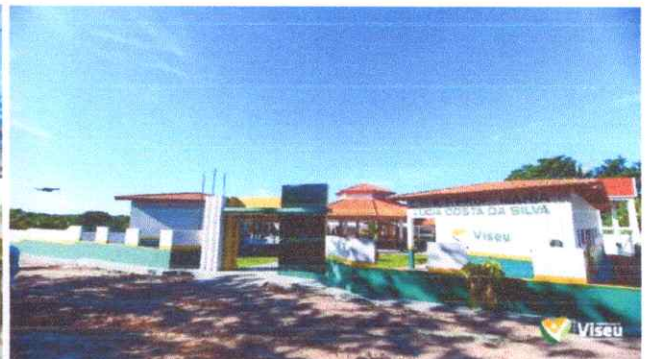
Imagem 16: Construção da escola.
