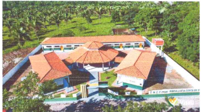
Imagem 14: Construção da escola
