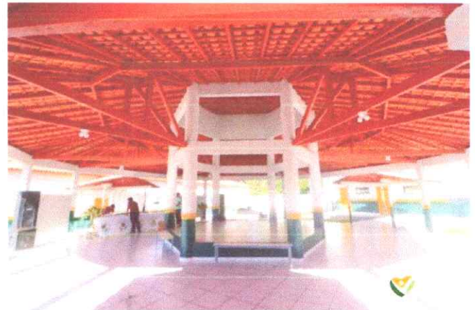
Imagem 08: Construção da escola
