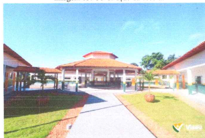
Imagem 05: Construção da escola.
