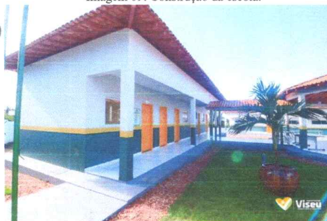
Imagem 11: Construção da escola.
