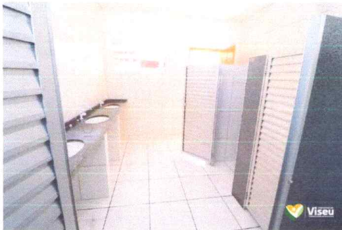
Imagem 07: Construção da escola.
