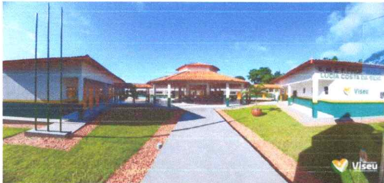
Imagem 15: Construção da escola.
