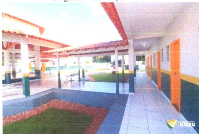
Imagem 03: Construção da escola.
