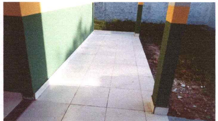
Imagem 04: Cerâmica assentada aguardando preenchimento de juntas.
