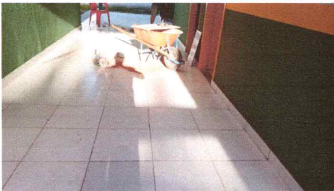
Imagem 03: Limpeza de preenchimento de juntas de assentamento entre placas cerâmicas.
