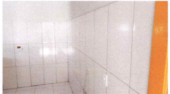
Imagem 02: Limpeza de preenchimento de juntas de assentamento entre placas cerâmicas.
