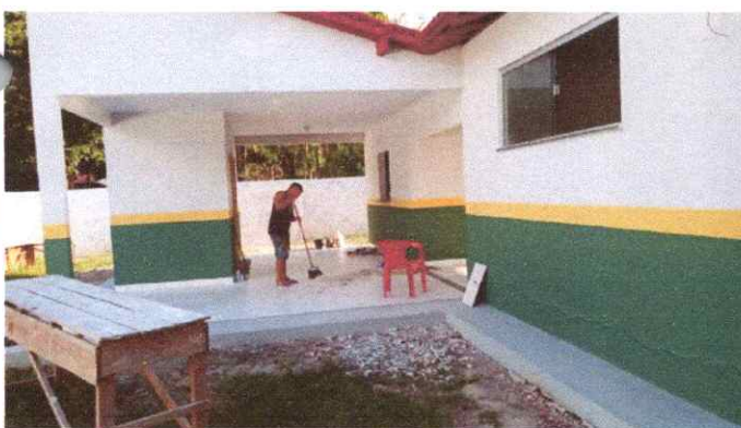
Imagem 05: Limpeza da obra.
