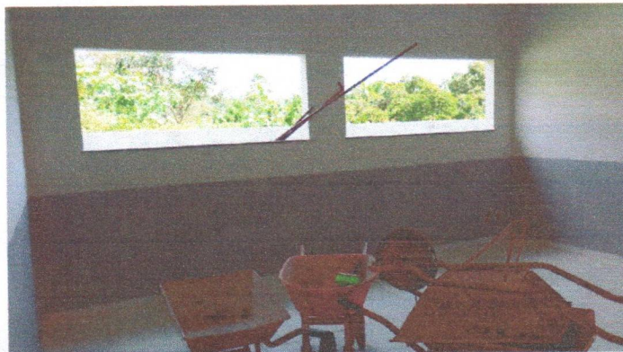
Imagem 01: Construção da escola.
