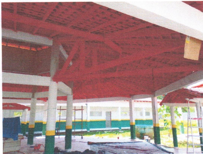
Imagem 07: Construção da escola.
