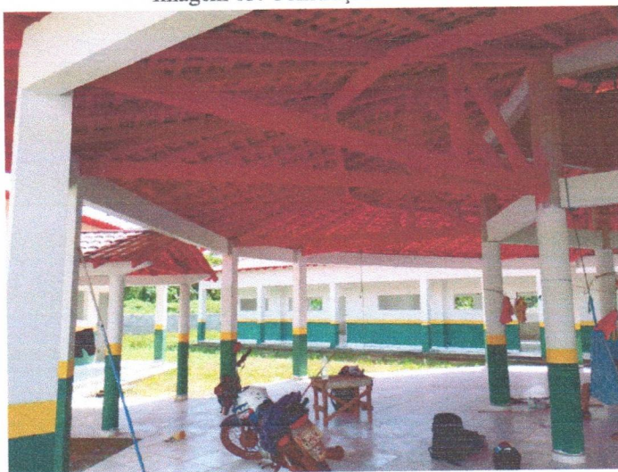
Imagem 05: Construção da escola.
