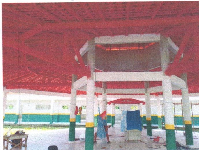
Imagem 06: Construção da escola.
