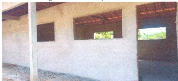
Imagem 07: Construção da escola.
