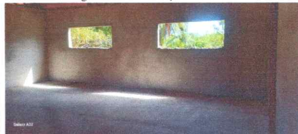
Imagem 08: Construção da escola.
