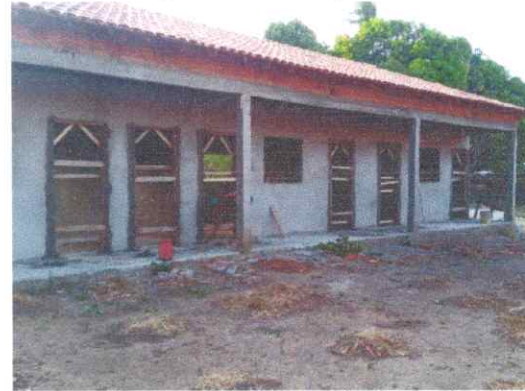
Imagem 04: Construção da escola.
