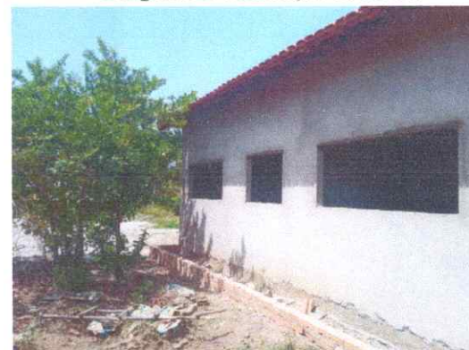
Imagem 06: Construção da escola.
