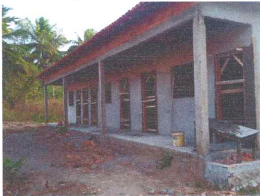
Imagem 03: Construção da escola.
