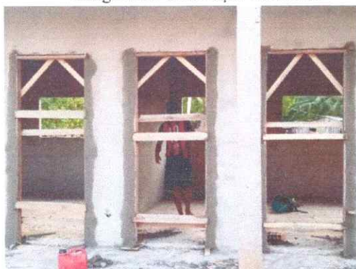
Imagem 05: Construção da escola.
