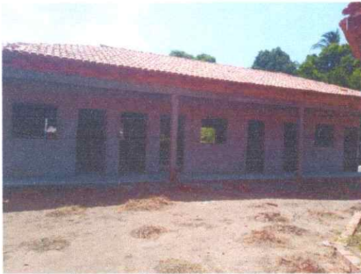
Imagem 01: Construção da escola.
