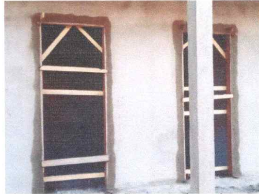
Imagem 02: Construção da escola
