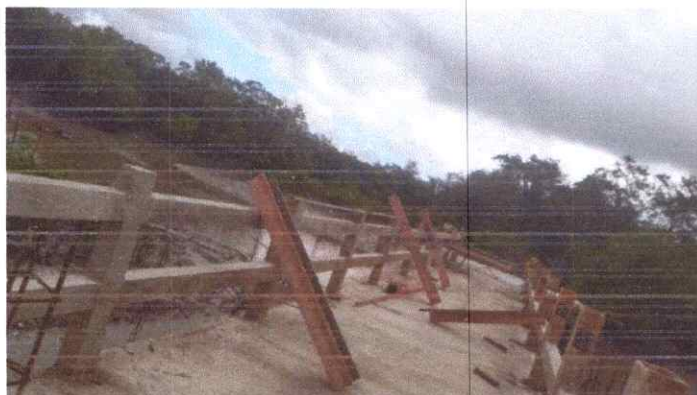
Imagem 07: Construção do trapiche.
