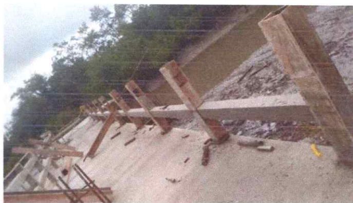
Imagem 02: Construção do trapiche.
