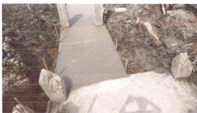
Imagem 08: Construção do trapiche.
