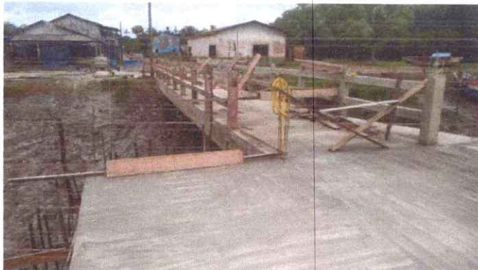
Imagem 01: Construção do trapiche.
