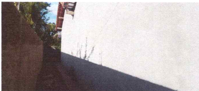
Imagem 08: Reforma da Escola Manoel Messias.
