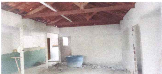
Imagem 07: Reforma da Escola Manoel Messias.
