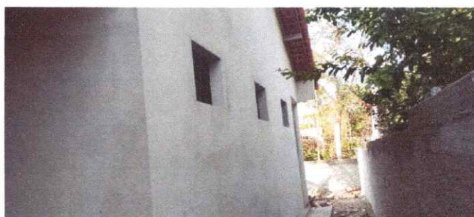
Imagem 04: Reforma da Escola Manoel Messias.
