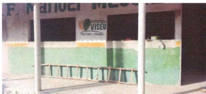
Imagem 03: Reforma da Escola Manoel Messias
