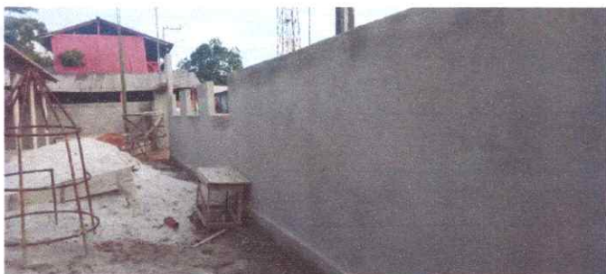
Imagem 05: Reforma da Escola Manoel Messias.
