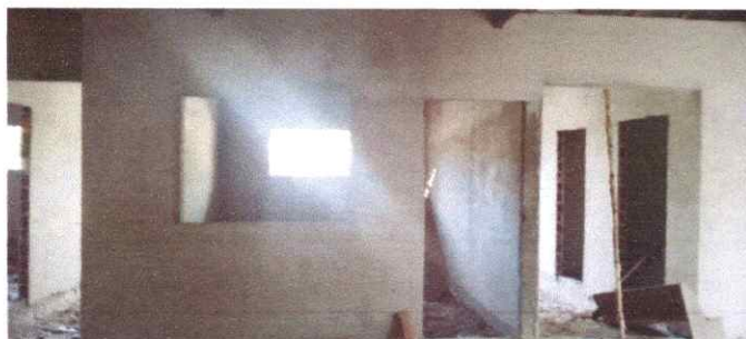
Imagem 09: Reforma da Escola Manoel Messias
