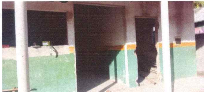
Imagem 02: Reforma da Escola Manoel Messias.
