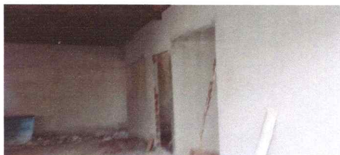
Imagem 06: Reforma da Escola Manoel Messias
