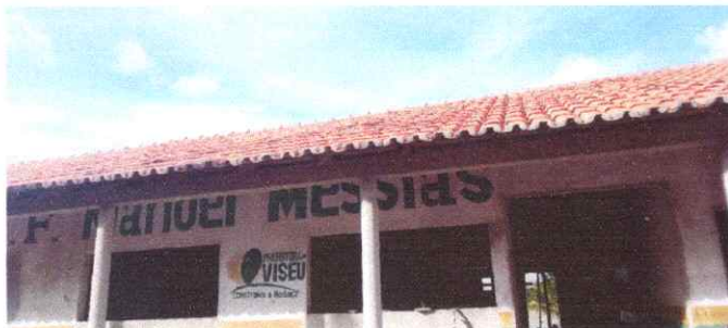
Imagem 01: Reforma da Escola Manoel Messias.
