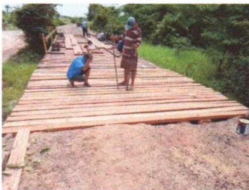
FOTO 05: Reforma de ponte.
