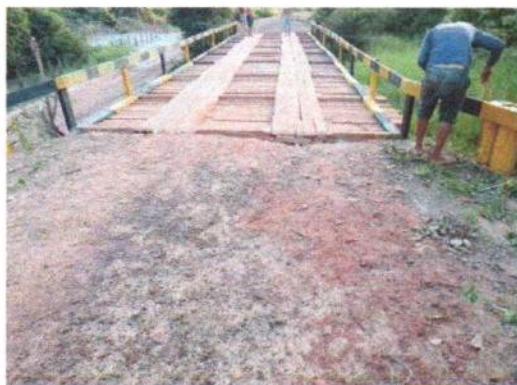
FOTO 07: Pintura de ponte.
