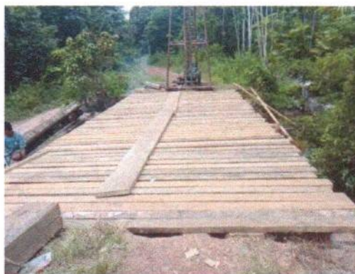
FOTO 06: Reforma de ponte.
