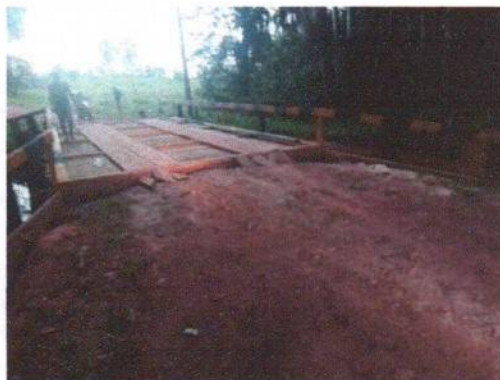
FOTO 02: Reforma de ponte.
