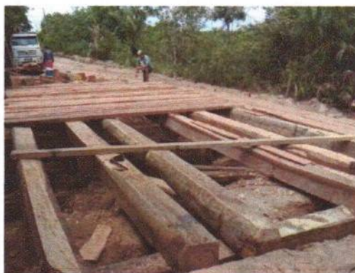
FOTO 08: Ponte em construção.
