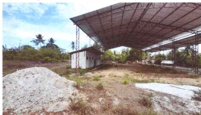
Imagem 04: Construção de quadra poliesportiva.
