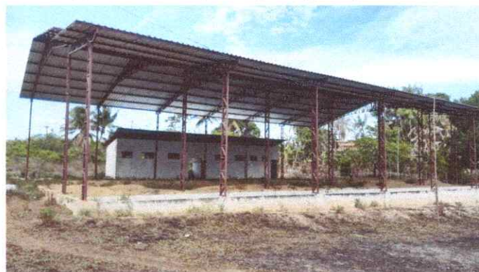
Imagem 06: Construção de quadra poliesportiva.
