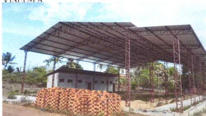
Imagem 01: Construção de quadra poliesportiva.
