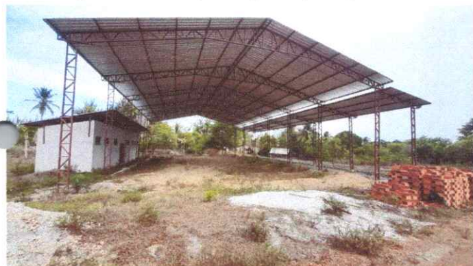
Imagem 05: Construção de quadra poliesportiva.
