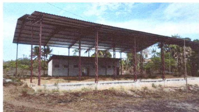
Imagem 07: Construção de quadra poliesportiva.
