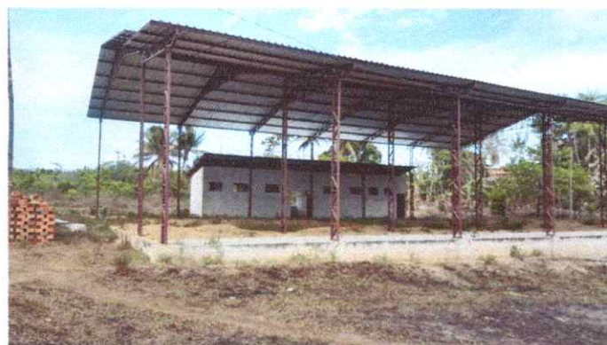
Imagem 08: Construção de quadra poliesportiva.
