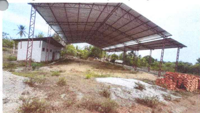
Imagem 03: Construção de quadra poliesportiva.
