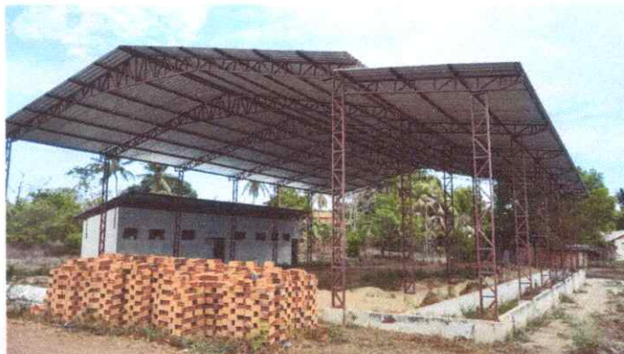
Imagem 02: Construção de quadra poliesportiva.
