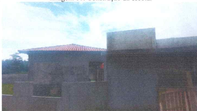
Imagem 03: Construção da escola.
