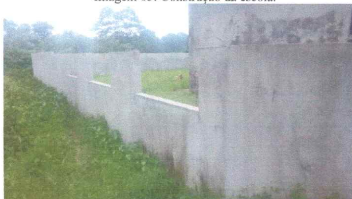
Imagem 07: Construção da escola.
