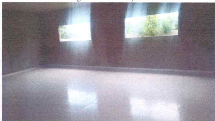
Imagem 04: Construção da escola.
