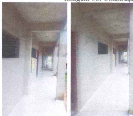
Imagem 08 e 09: Construção da escola.
