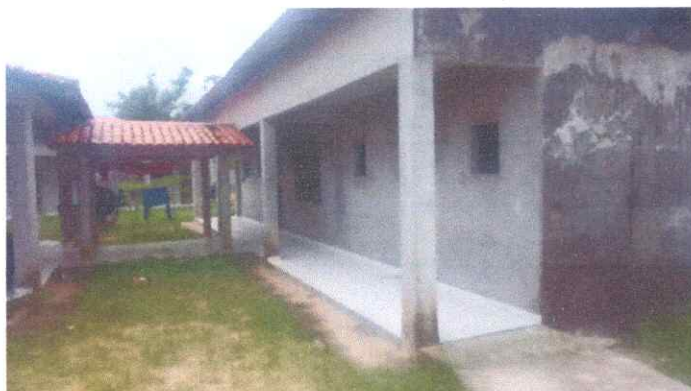
Imagem 01: Construção da escola.
