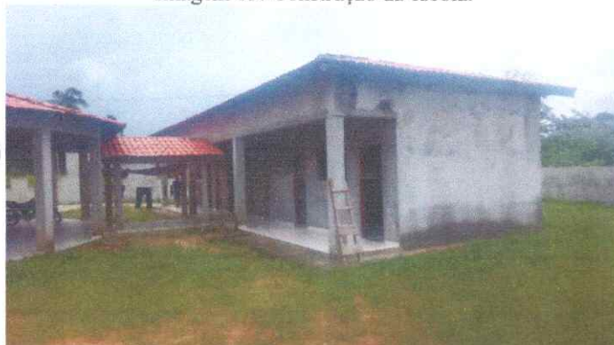
Imagem 05: Construção da escola.
