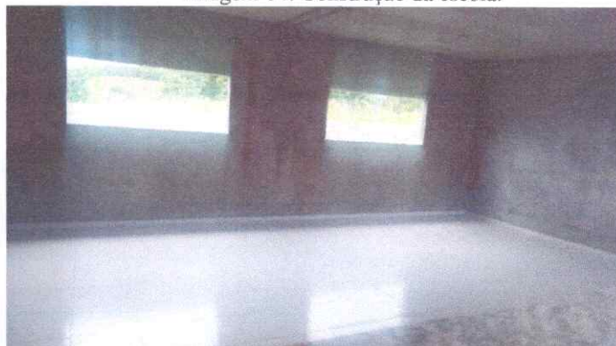
Imagem 06: Construção da escola.
