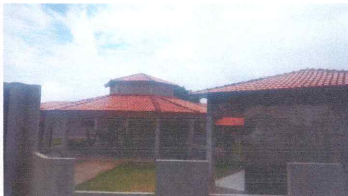
Imagem 02: Construção da escola
