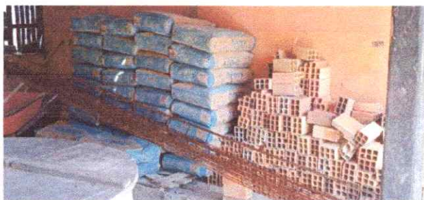
Imagem 02: Construção da UBS em Carrapatinho
