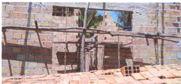
Imagem 01: Construção da UBS em Carrapatinho.
