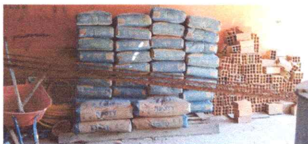
Imagem 03: Construção da UBS em Carrapatinho
