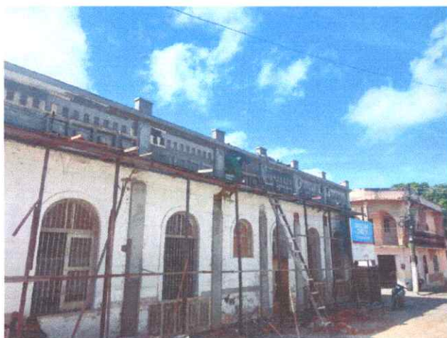
Imagem 03: Execução da reforma.
