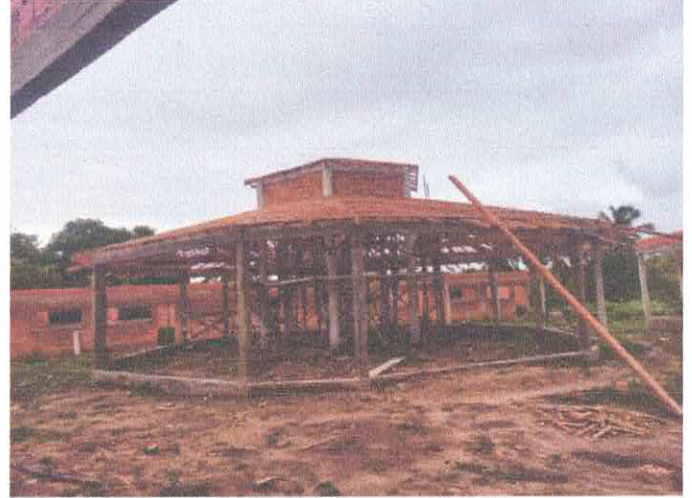
Imagem 02: Vista central da obra.
