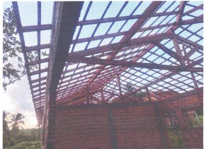
Imagem 04: Vista da estrutura do telhado.
