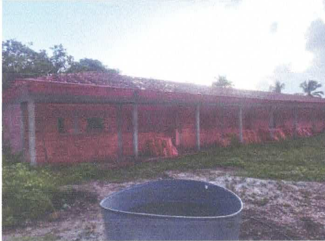
Imagem 01: Vista do bloco de salas.
