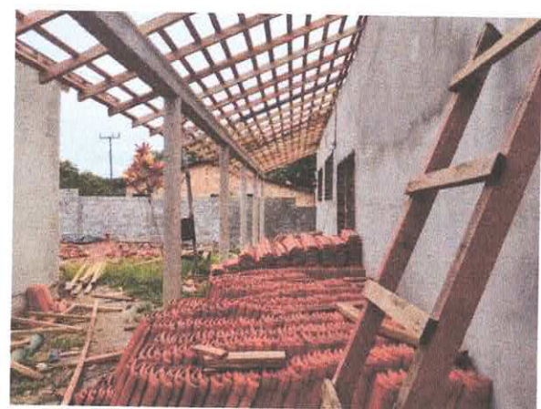
EXECUÇÃO DE COBERTURA DO BEIRAL
