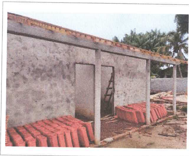
PILARES E VIGAS AMPLIAÇÃO
