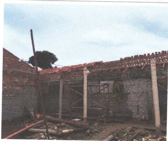
PILARES, VIGA SUPERIOR E REBOCO
