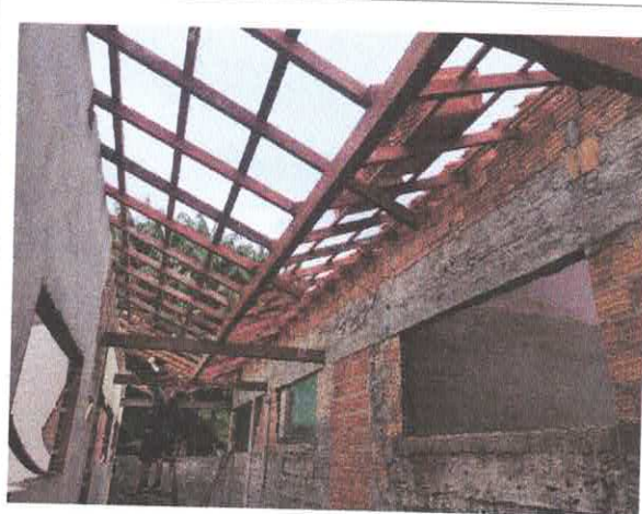
EXECUÇÃO DE COBERTURA CORREDOR
