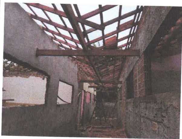
EXECUÇÃO DE COBERTURA CORREDOR
