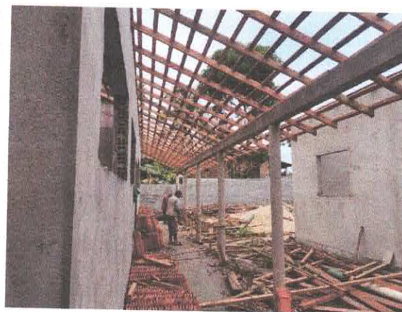
VISTA BLOCO REFORMA
