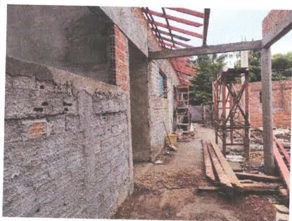
RECOMPOSIÇÃO DE REBOCO
