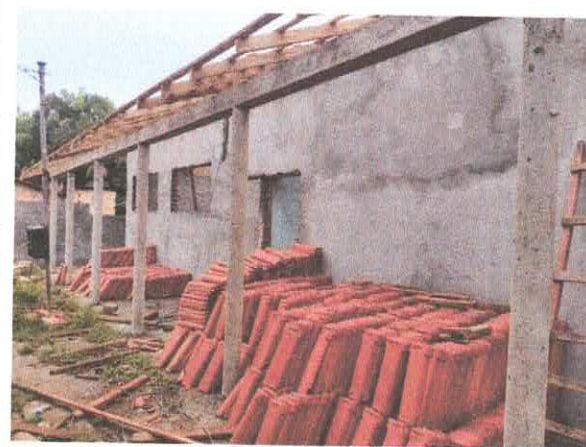
EXECUÇÃO DE COBERTURA DO BEIRAL
