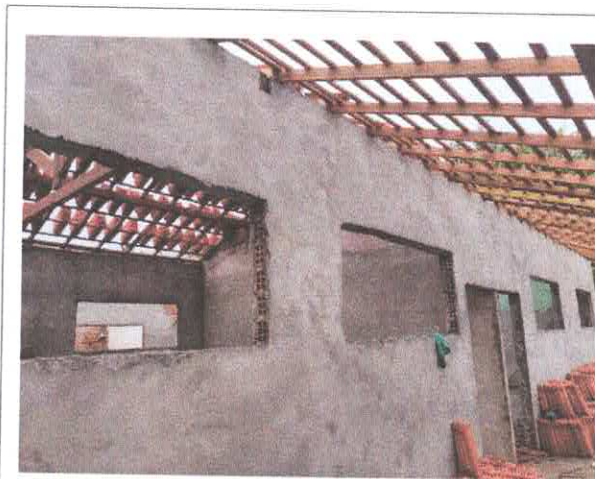
REBOCO AMPLIAÇÃO
