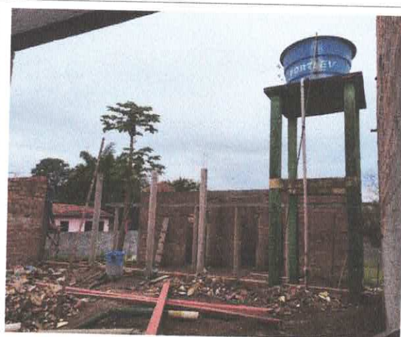
VISTA PILARES E VIGA SUPERIOR
