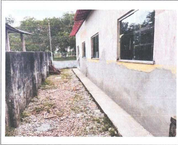
RECOMPOSIÇÃO DE REBOCO
