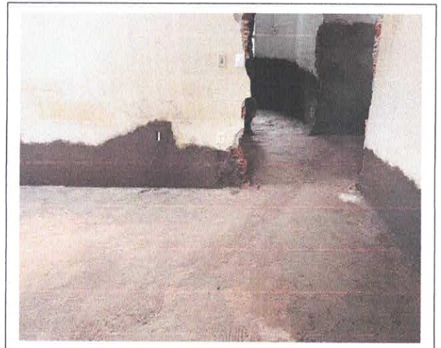
RECOMPOSIÇÃO DE REBOCO
