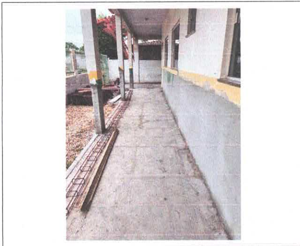
DEMOLIÇÃO DE PISO CERÂMICO
