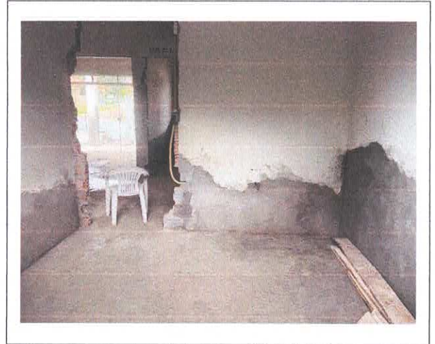
RECOMPOSIÇÃO DE REBOCO
