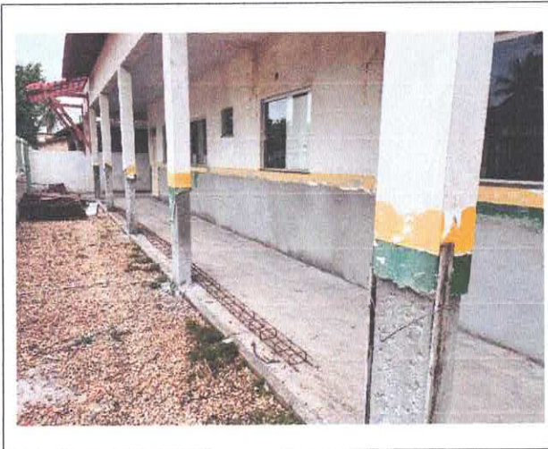
DEMOLIÇÃO DE REVESTIMENTO
