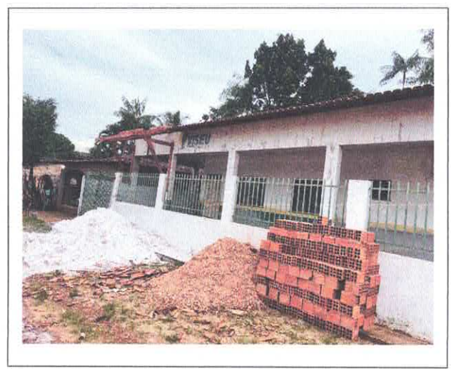
VISTA FRENTE DA OBRA
