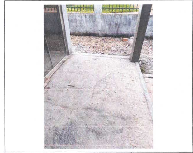
DEMOLIÇÃO DE PISO CERÂMICO
