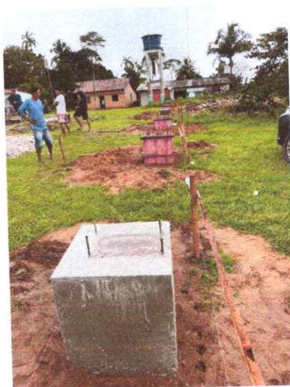
FOTO 03: Processo de desforma.
