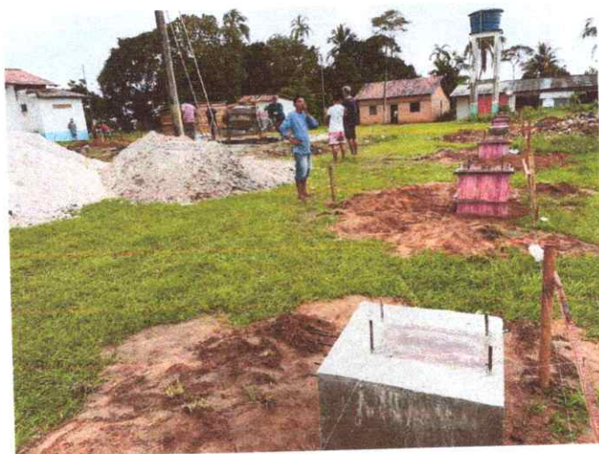
FOTO 02: Processo de desforma.
