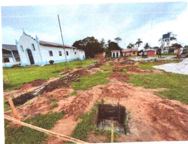
FOTO 01: Pilares em fase de concretagem.
