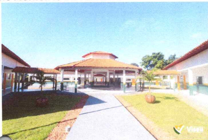
Imagem 01: Construção da Escola Gregório Coelho.
