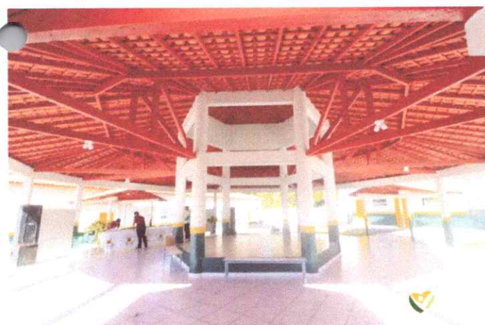
Imagem 05: Construção da Escola Gregório Coelho.
