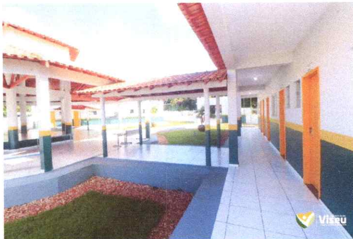
Imagem 02: Construção da Escola Gregório Coelho.
