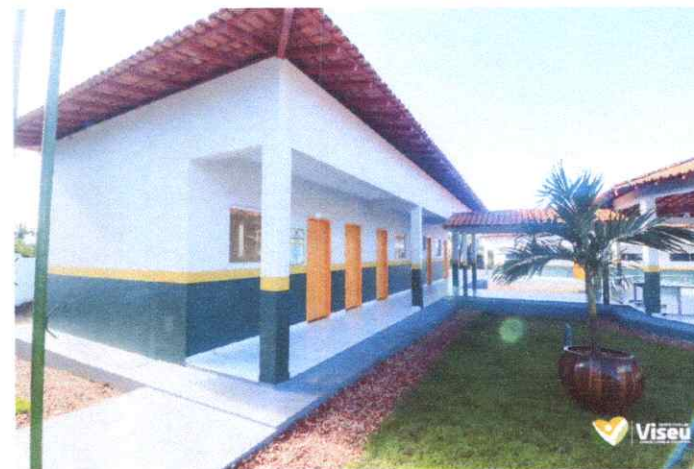
Imagem 06: Construção da Escola Gregório Coelho.
