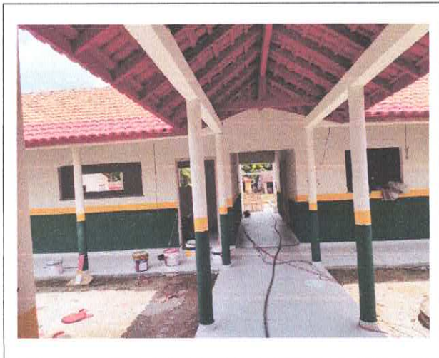
VISTA EXTERNA PASSARELA
