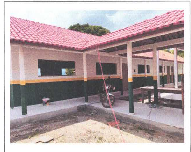
VISTA EXTERNA PASSARELA
