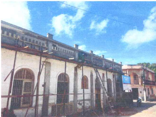
Imagem 03: Execução da reforma.
