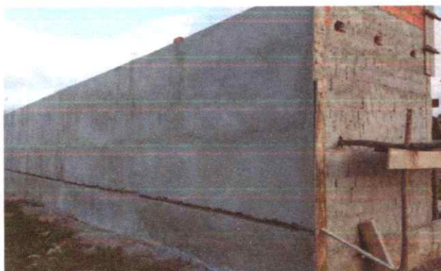
FOTO 03: Alvenaria com reboco.
