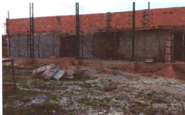
FOTO 02: Vestiário em construção.
