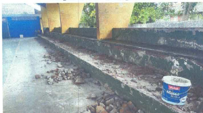
Imagem 11: reforma de ginásio.
