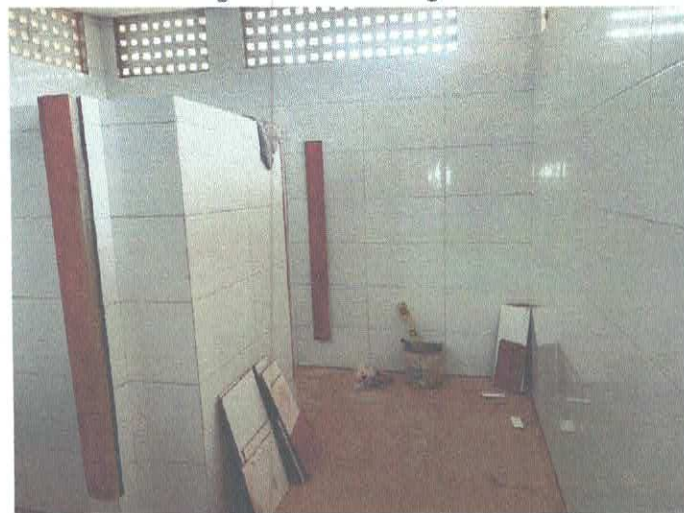
Imagem 09: reforma de ginásio.
