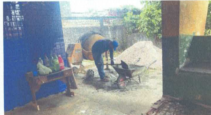
Imagem 12: reforma de ginásio.
