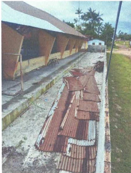
Imagem 01: reforma de ginásio.
