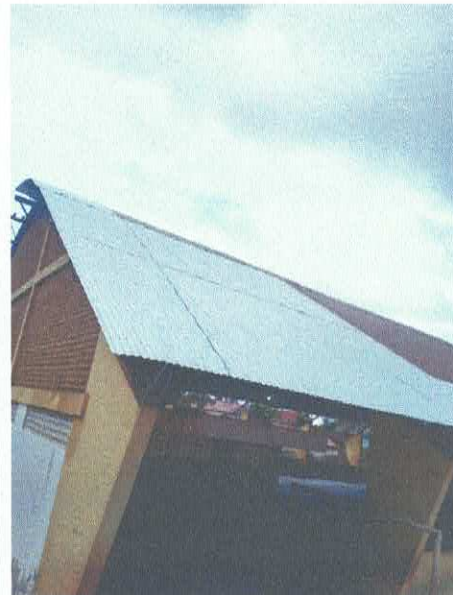
Imagem 03: reforma de ginásio.
