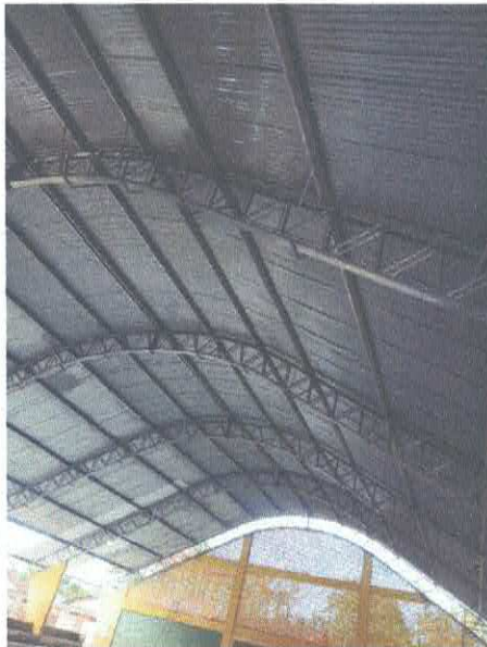
Imagem 02: reforma de ginásio.
