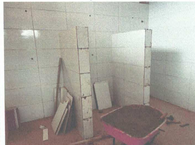
Imagem 10: reforma de ginásio.
