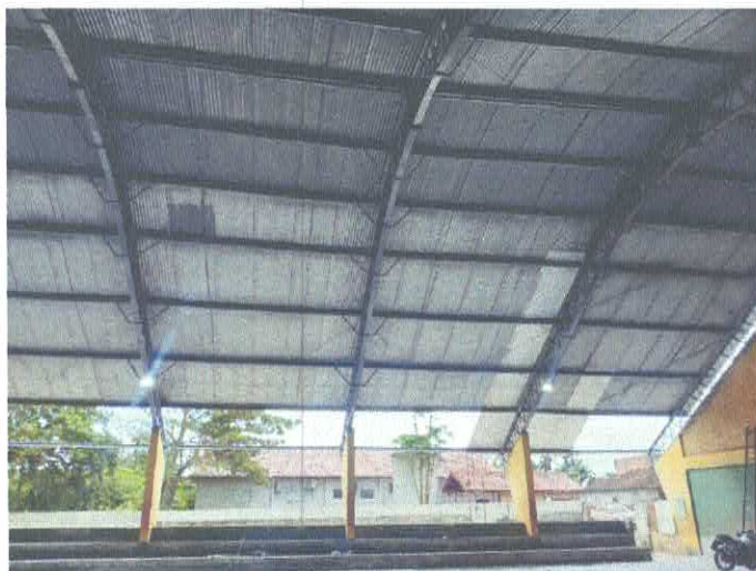
Imagem 07: reforma de ginásio.
