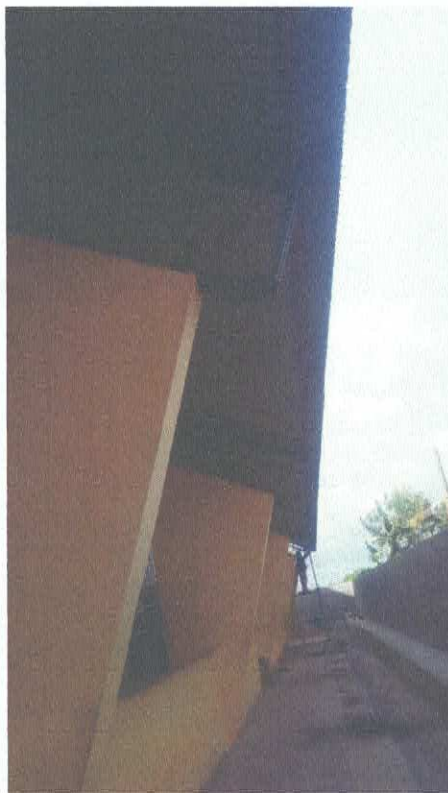
Imagem 05: reforma de ginásio
