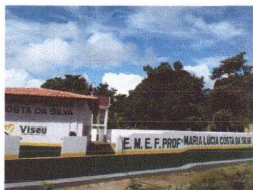
FOTO 08: Muro da escola.
