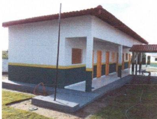
FOTO 04: Bloco de salas.
