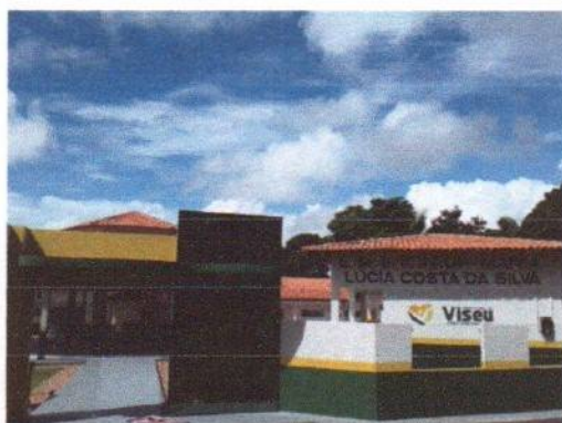
FOTO 05: Detalhe da fachada.
