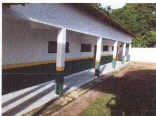
FOTO 07: Blocos de salas de aula.
