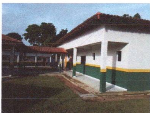
FOTO 03: Detalhe dos blocos.
