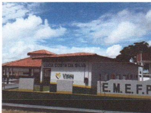
FOTO 01: Detalhe da escola.
