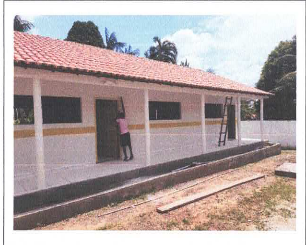
VISTA BLOCO PEDAGÓGICO
