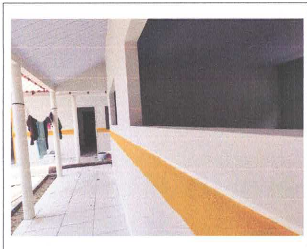
PINTURA DE PAREDES
