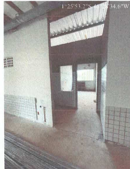
Imagem 15: Construção de creche.
