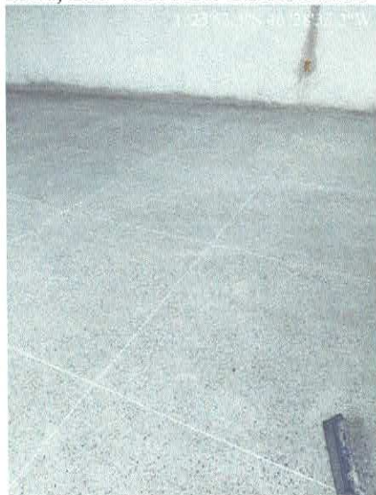
Imagem 07: Construção de creche.
