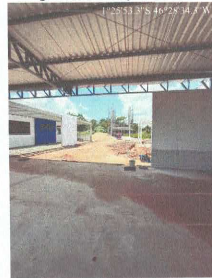
Imagem 18: Construção de creche.
