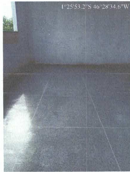
Imagem 09: Construção de creche.
