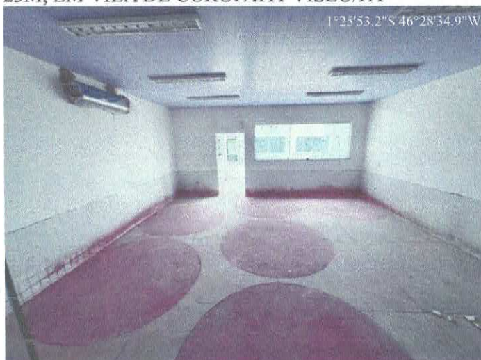
Imagem 01: Construção de creche.
