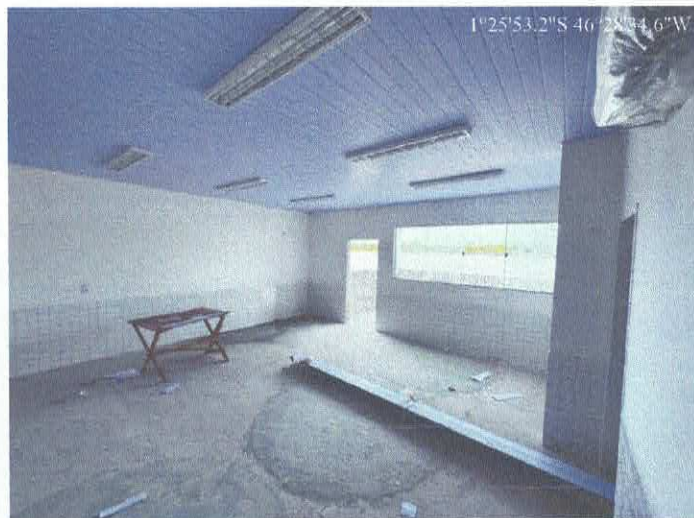
Imagem 02: Construção de creche.
