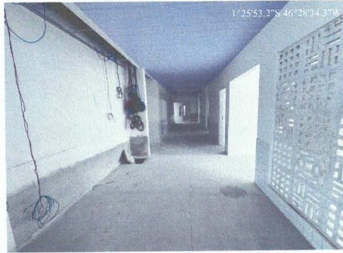
Imagem 06: Construção de creche.
