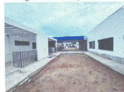
Imagem 20: Construção de creche.
