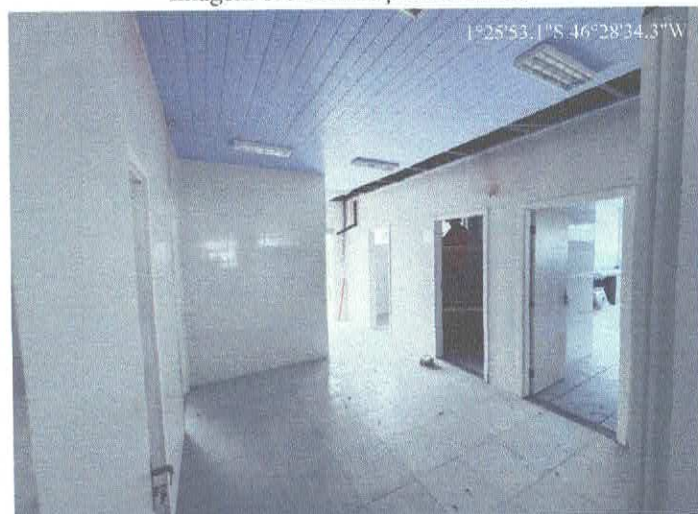
Imagem 05: Construção de creche.
