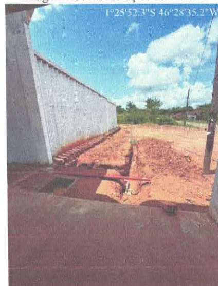
Imagem 16: Construção de creche.
