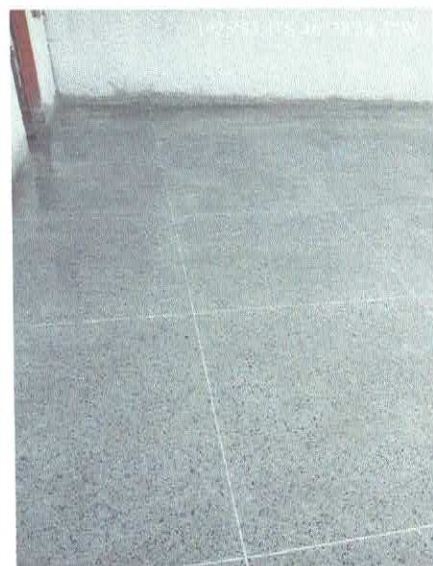
Imagem 10: Construção de creche.
