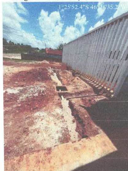
Imagem 17: Construção de creche.
