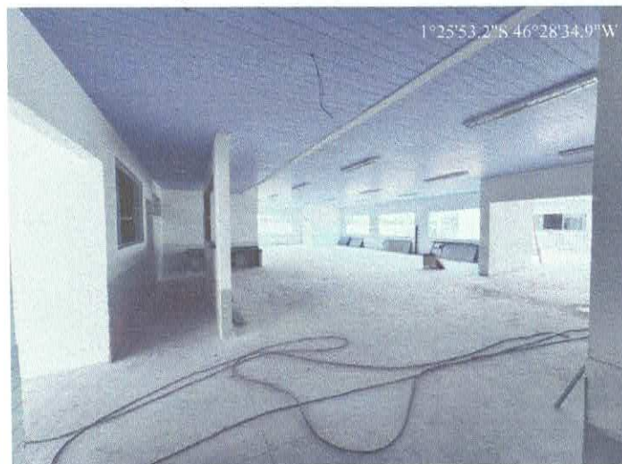
Imagem 03: Construção de creche.
