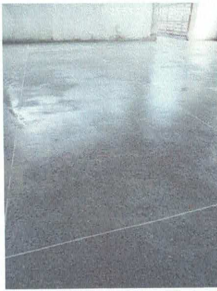
Imagem 11: Construção de creche.
