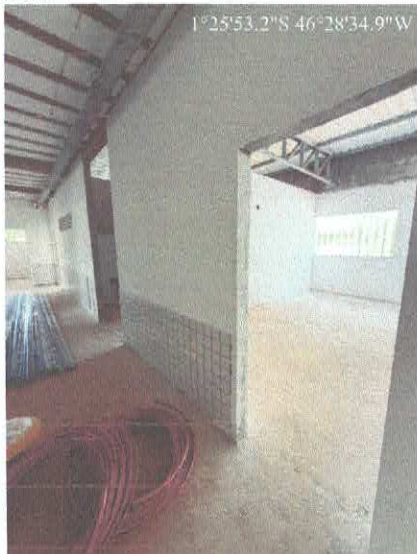
Imagem 14: Construção de creche.
