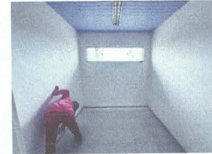
Imagem 21: Construção de creche.
