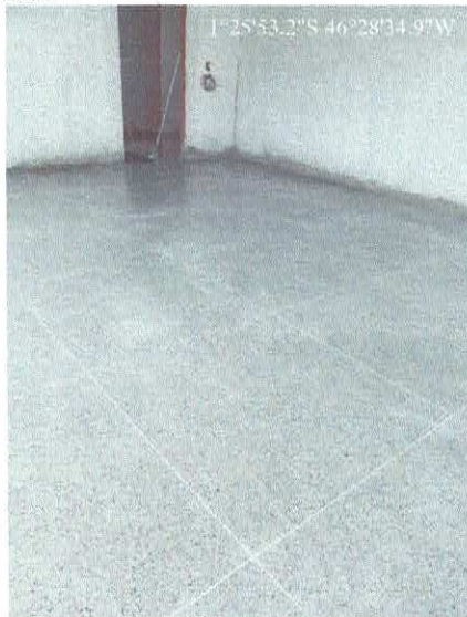
Imagem 08: Construção de creche.
