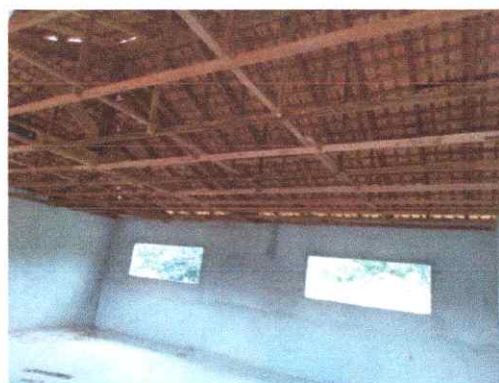
FOTO 04: Detalhes do telhado.
