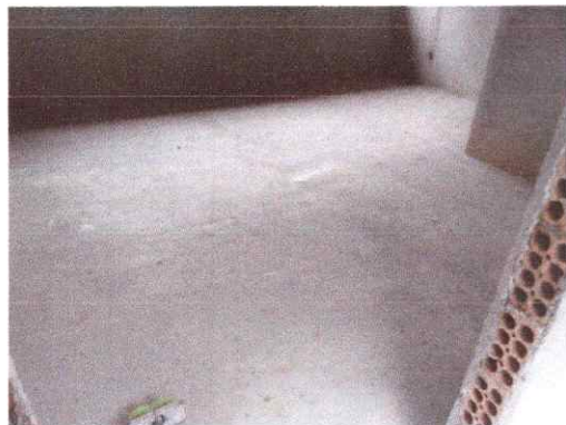
FOTO 01: Detalhe do piso.
