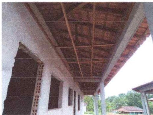
FOTO 05: Detalhe da cobertura da varanda.
