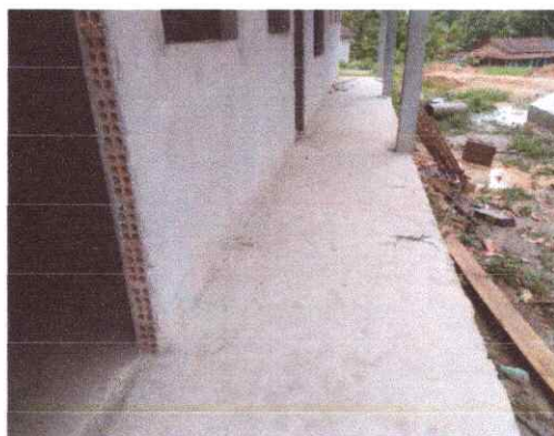
FOTO 08: Alvenaria com rebôco.
