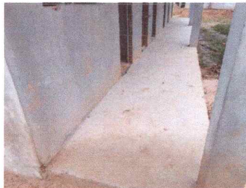
FOTO 06: Detalhe do piso em construção.
