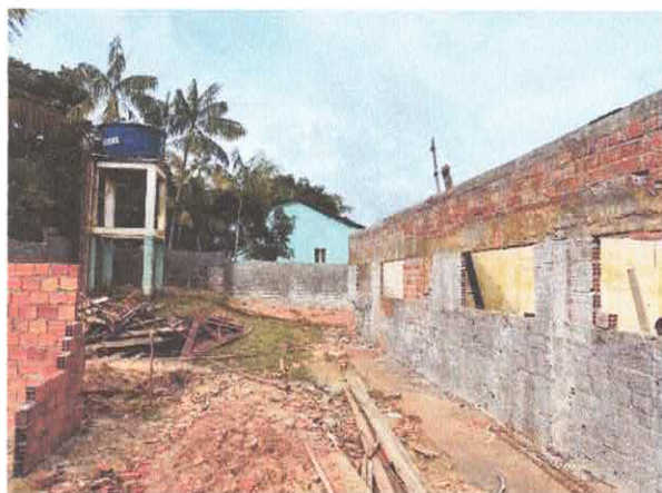
RECOMPOSIÇÃO DE REBOCO
