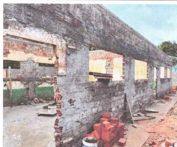
RECOMPOSIÇÃO DE REBOCO
