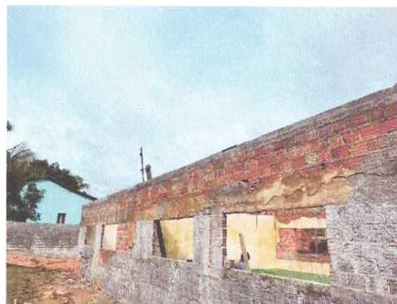
RECOMPOSIÇÃO DE REBOCO
