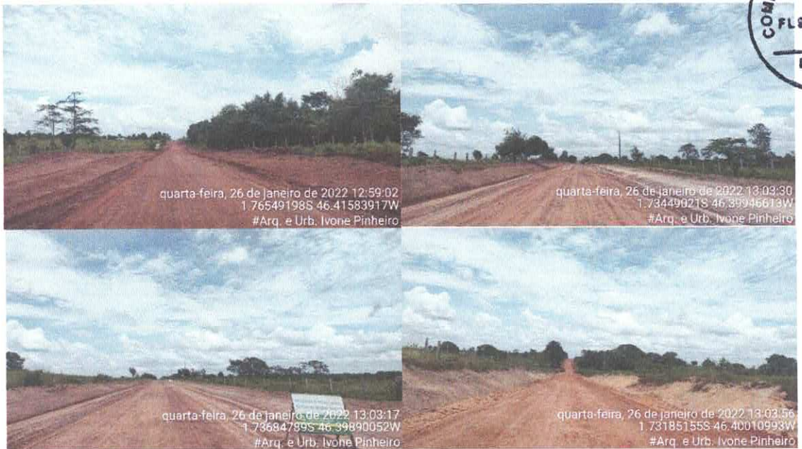
Figura 1 - Desmatamento e Terraplenagem
