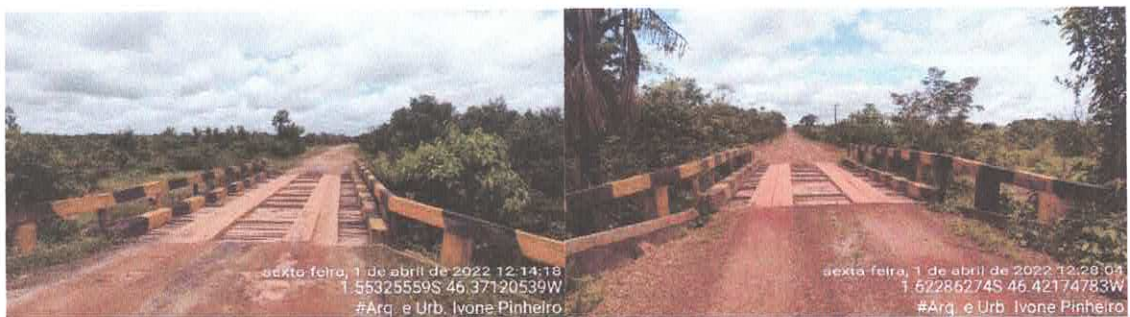
Figura 3 - Obras de artes especiais
