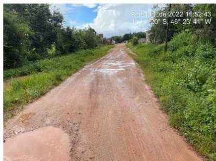
Rua Princal- Comunidade do Laguinho
