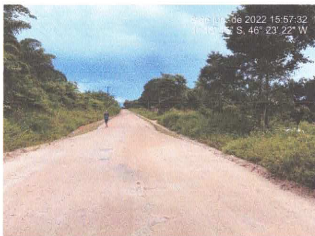
Rua Principal- Comunidade do Lagunho
