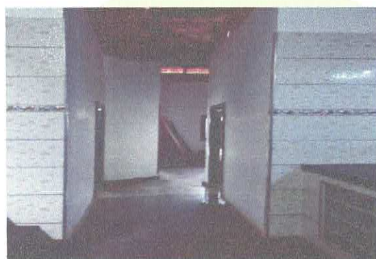
03 – Revestimento e Pinturas das paredes
