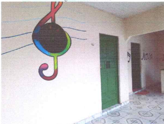
Imagem 05: Alvenaria com revestimento
