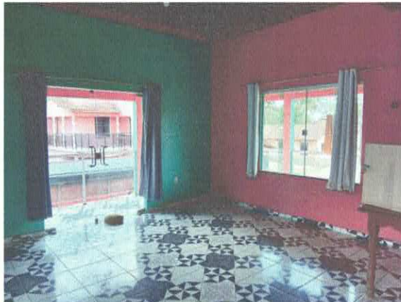
Imagem 08: Esquadrias de vidro
