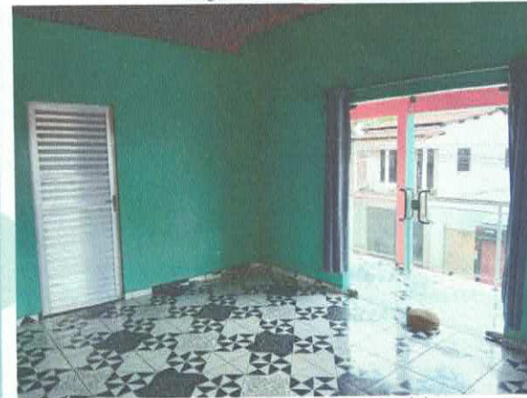
Imagem 06: Portas de vidro e alumínio
