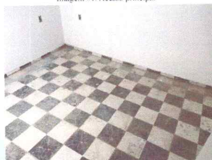
Imagem 03: Piso com Revestimento Cerâmico
